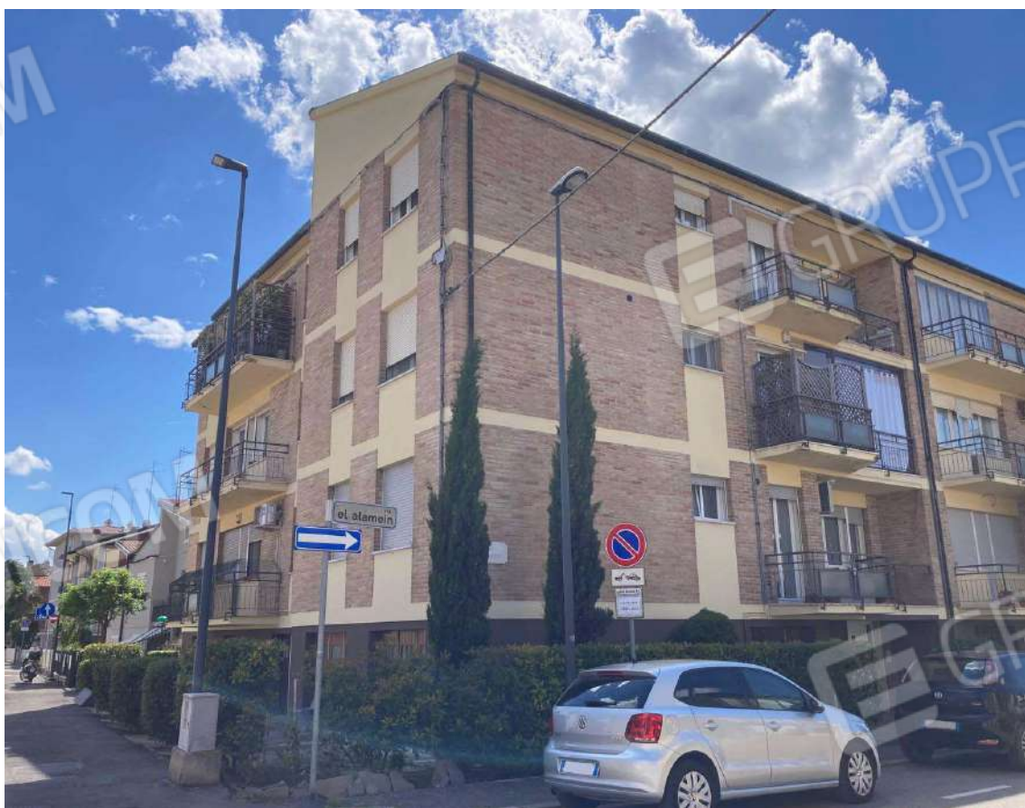
Vista esterna del fabbricato ad uso residenziale lato est
