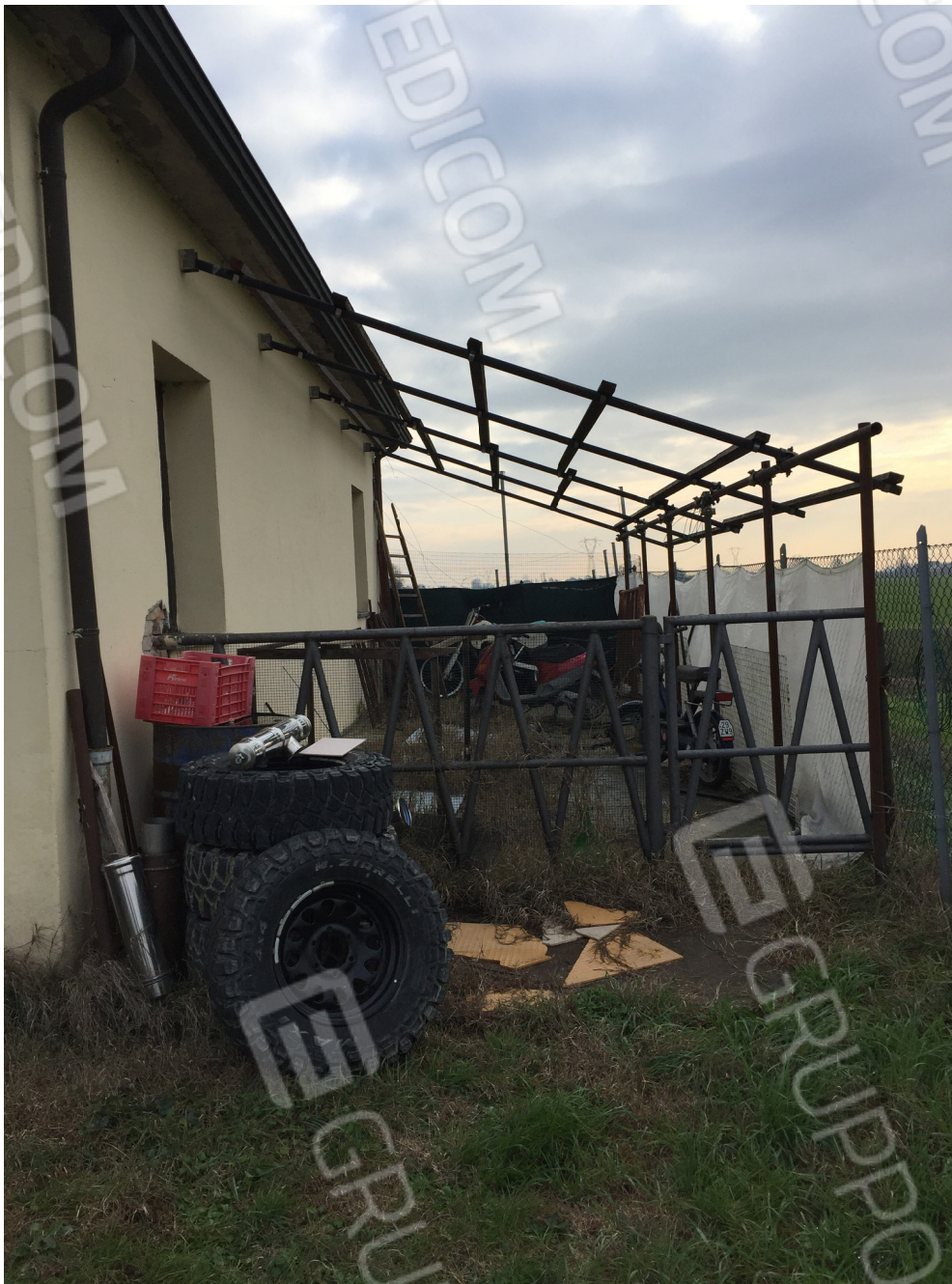
Foto 12 - Tettoia corpo servizi
