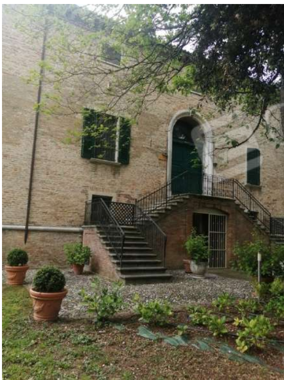
Foto ingresso principale ufficio
