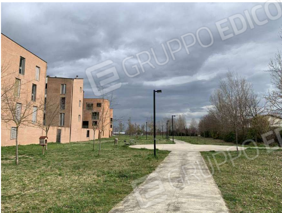
Foto 11: Esterni – area circostante
