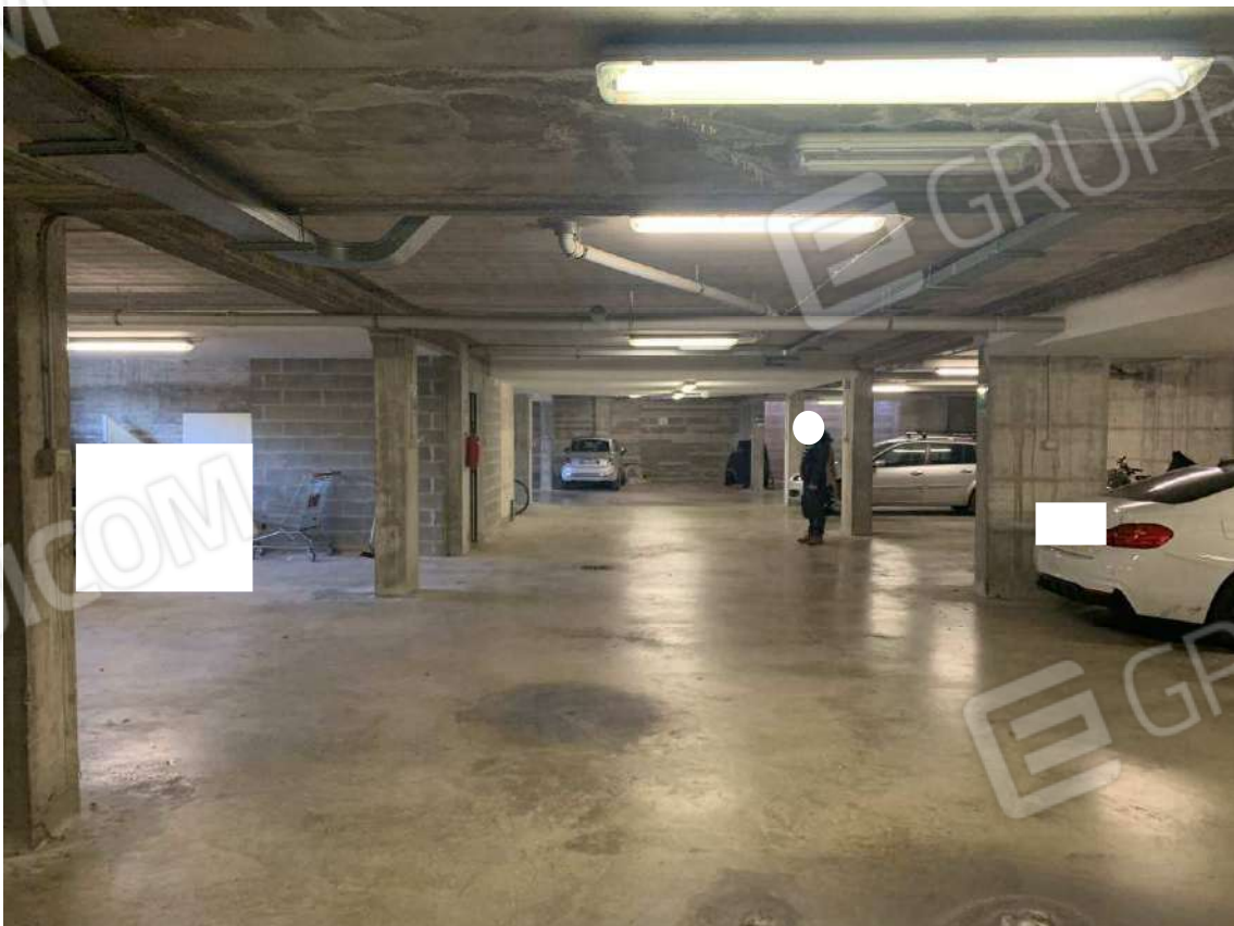
Foto 33: Passaggio carrabile comune – Fabbricato B
