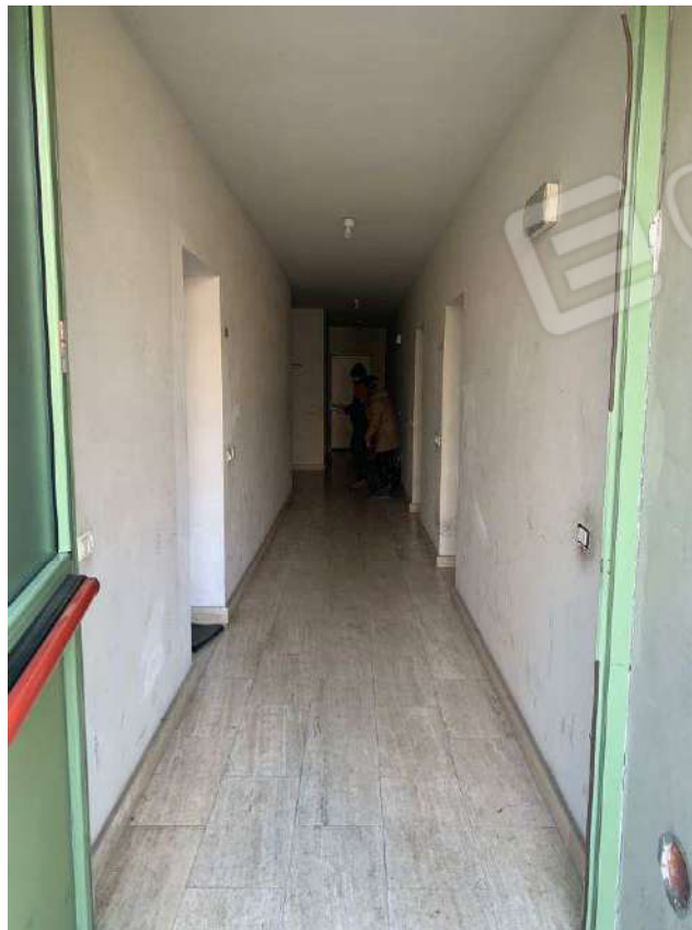
Foto 14: Parti comuni – Fabbricato B
