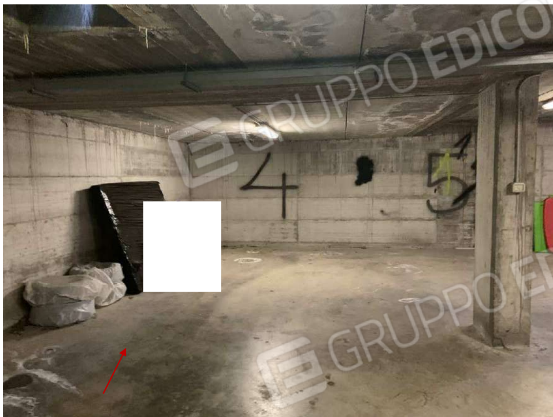
Foto 34: Parcheggio coperto, subalterno 75
