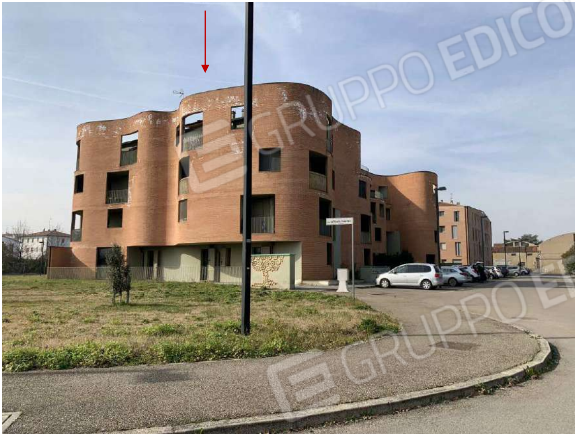
Foto 7: Esterni – Fabbricato B
