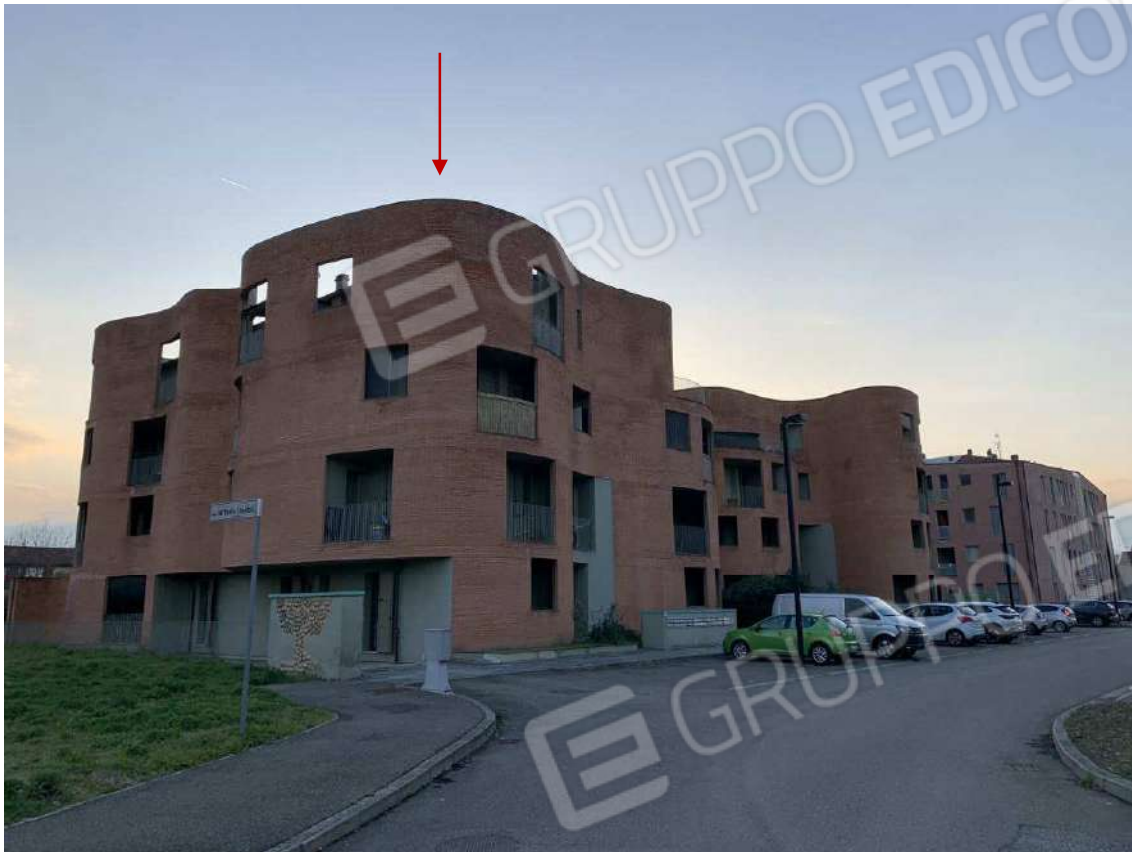
Foto 5: Esterni – Fabbricato B
