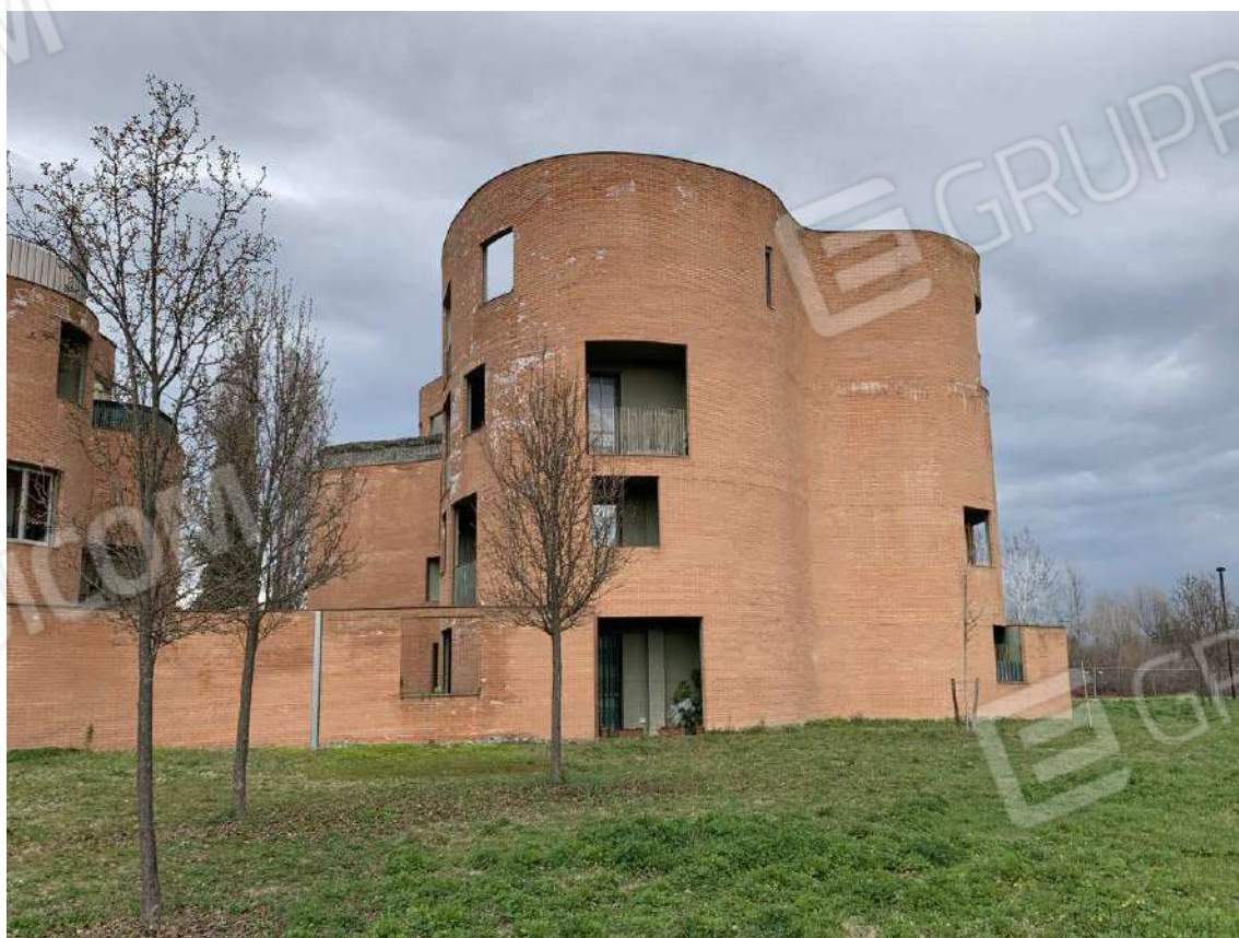
Foto 6: Esterni – Fabbricato B
