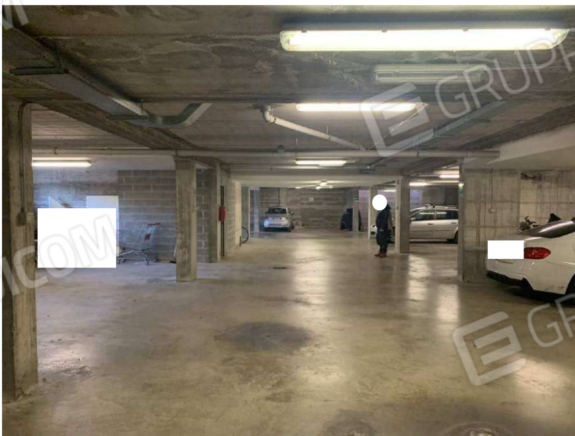
Foto 33: Passaggio carrabile comune – Fabbricato B
