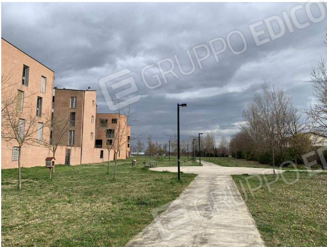
Foto 11: Esterni – area circostante
