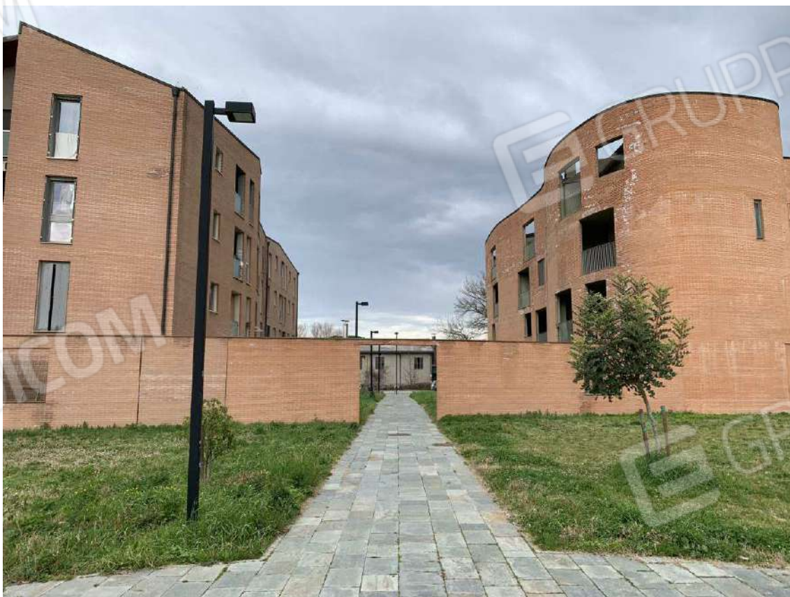
Foto 12: Esterni – area circostante
