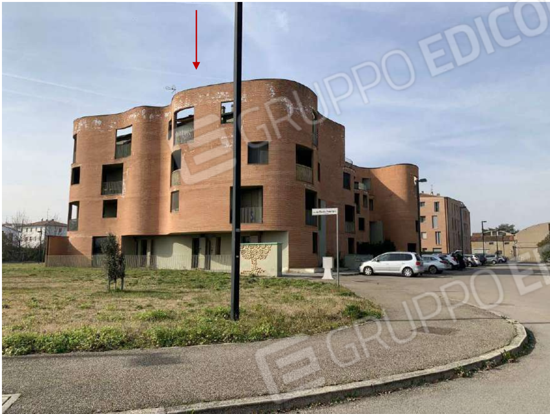
Foto 7: Esterni – Fabbricato B
