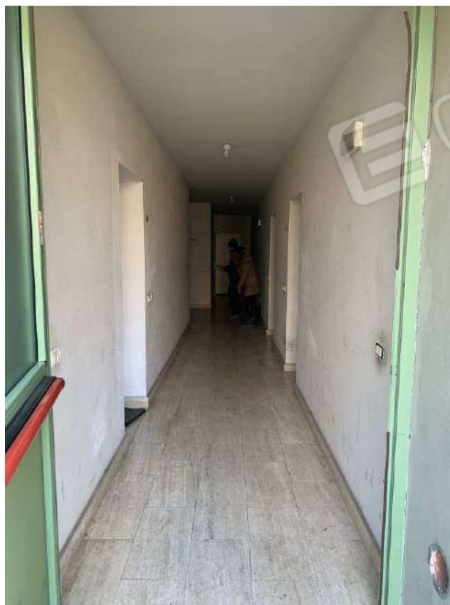
Foto 14: Parti comuni – Fabbricato B
