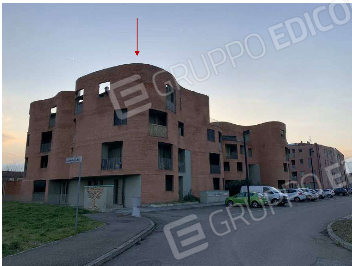
Foto 5: Esterni – Fabbricato B
