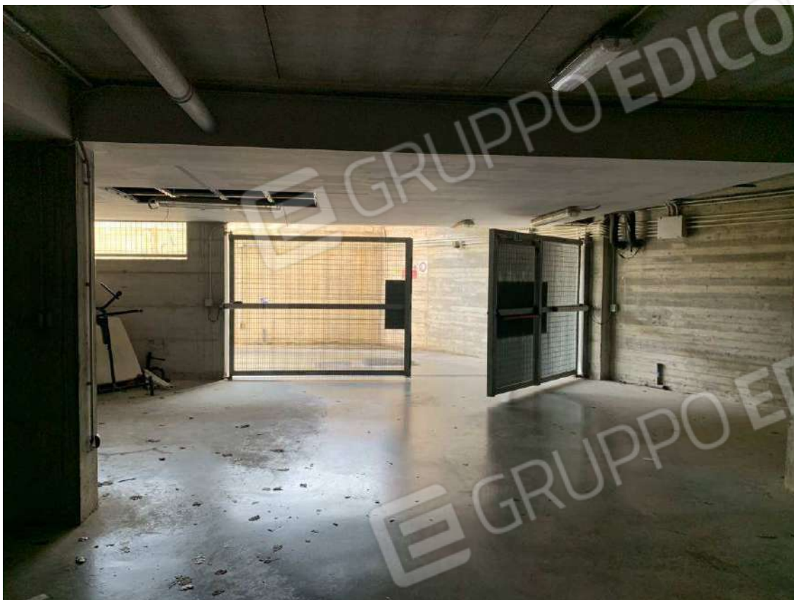
Foto 32: Passaggio carrabile comune – Fabbricato B
