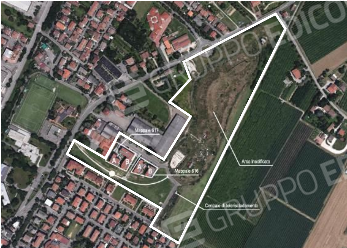
Foto 1: Vista aerea – Perimetro area di interesse
