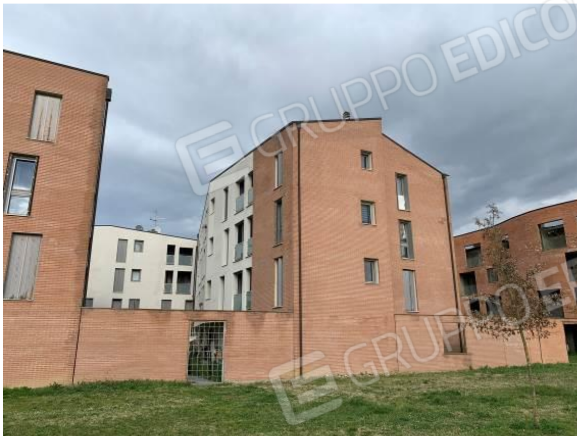
Foto 7: Esterni – Fabbricato B
