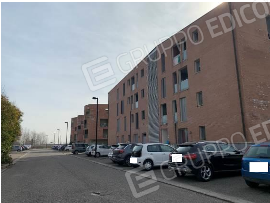
Foto 5: Esterni – Fabbricato B
