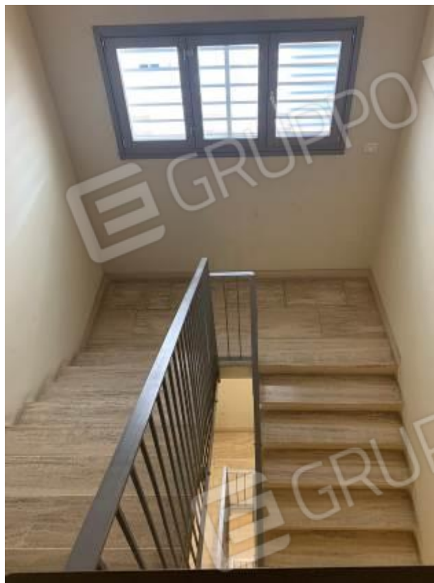
Foto 15: Parti comuni – Fabbricato B
