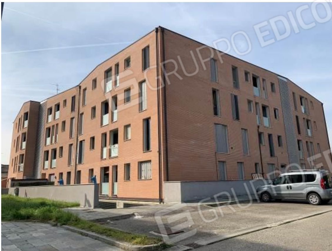
Foto 3: Esterni – Fabbricato B
