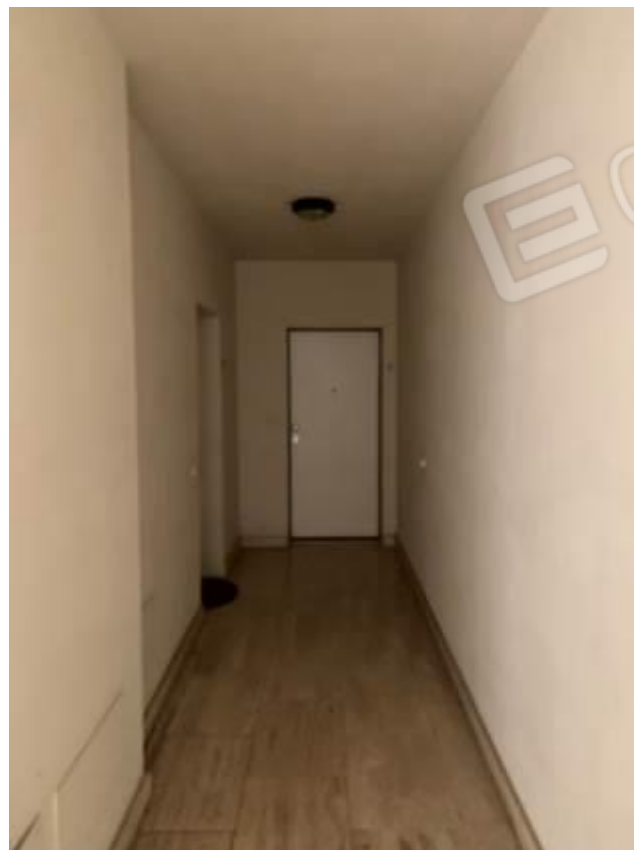
Foto 14: Parti comuni – Fabbricato B
