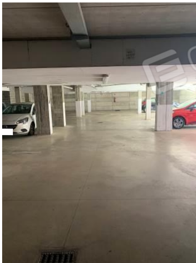
Foto 33: Passaggio carrabile comune – Fabbricato B
