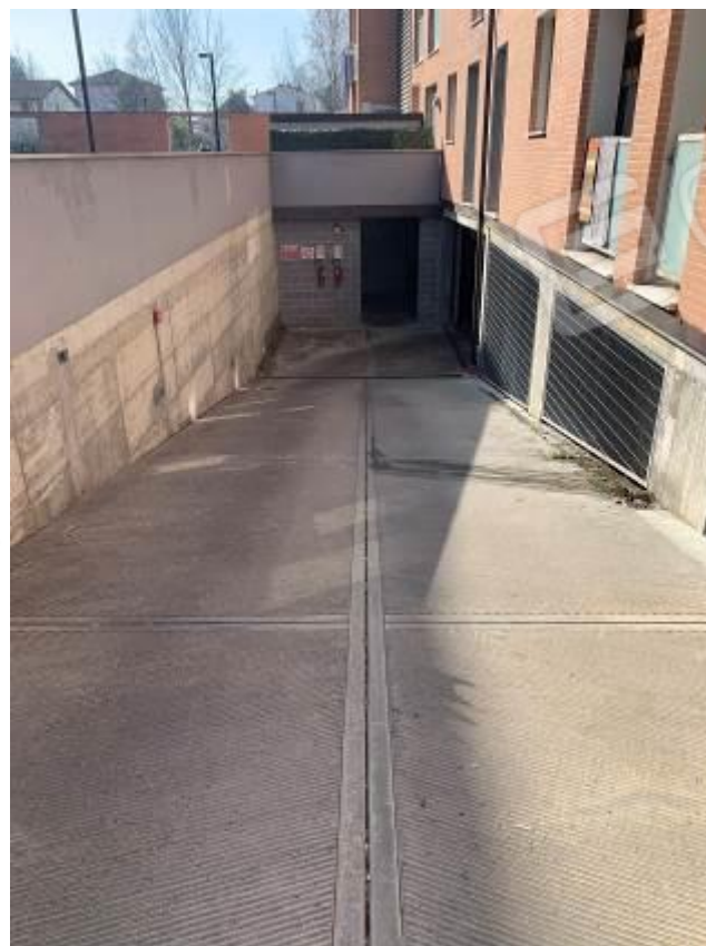
Foto 31: Accesso ai garage – Fabbricato B
