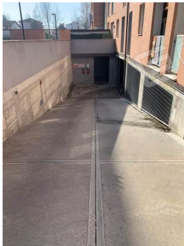
Foto 29: Accesso ai garage – Fabbricato B
