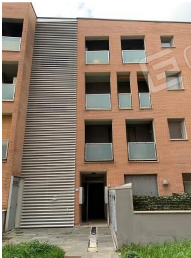
Foto 6: Esterni – Fabbricato B
