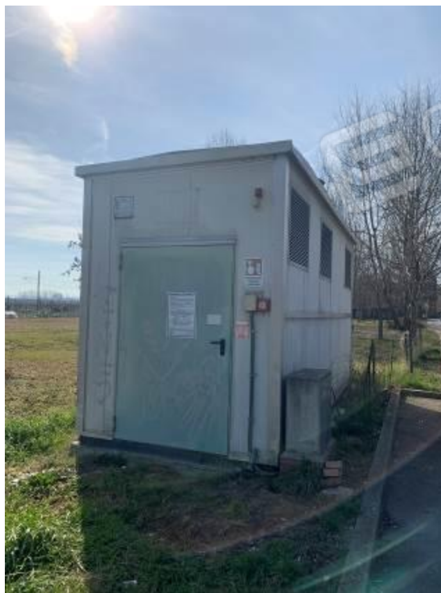
Foto 33: Centrale di teleriscaldamento
