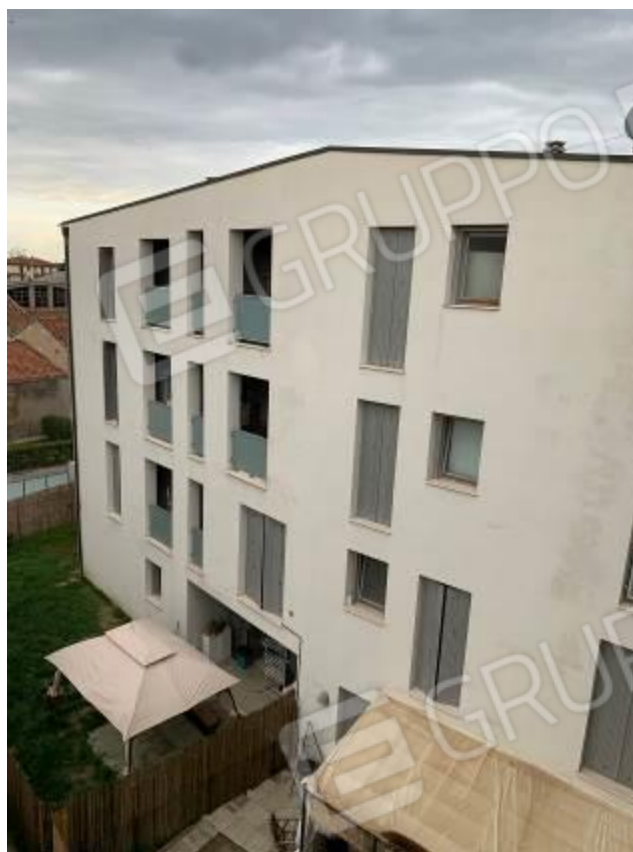
Foto 9: Esterni – Fabbricato B
