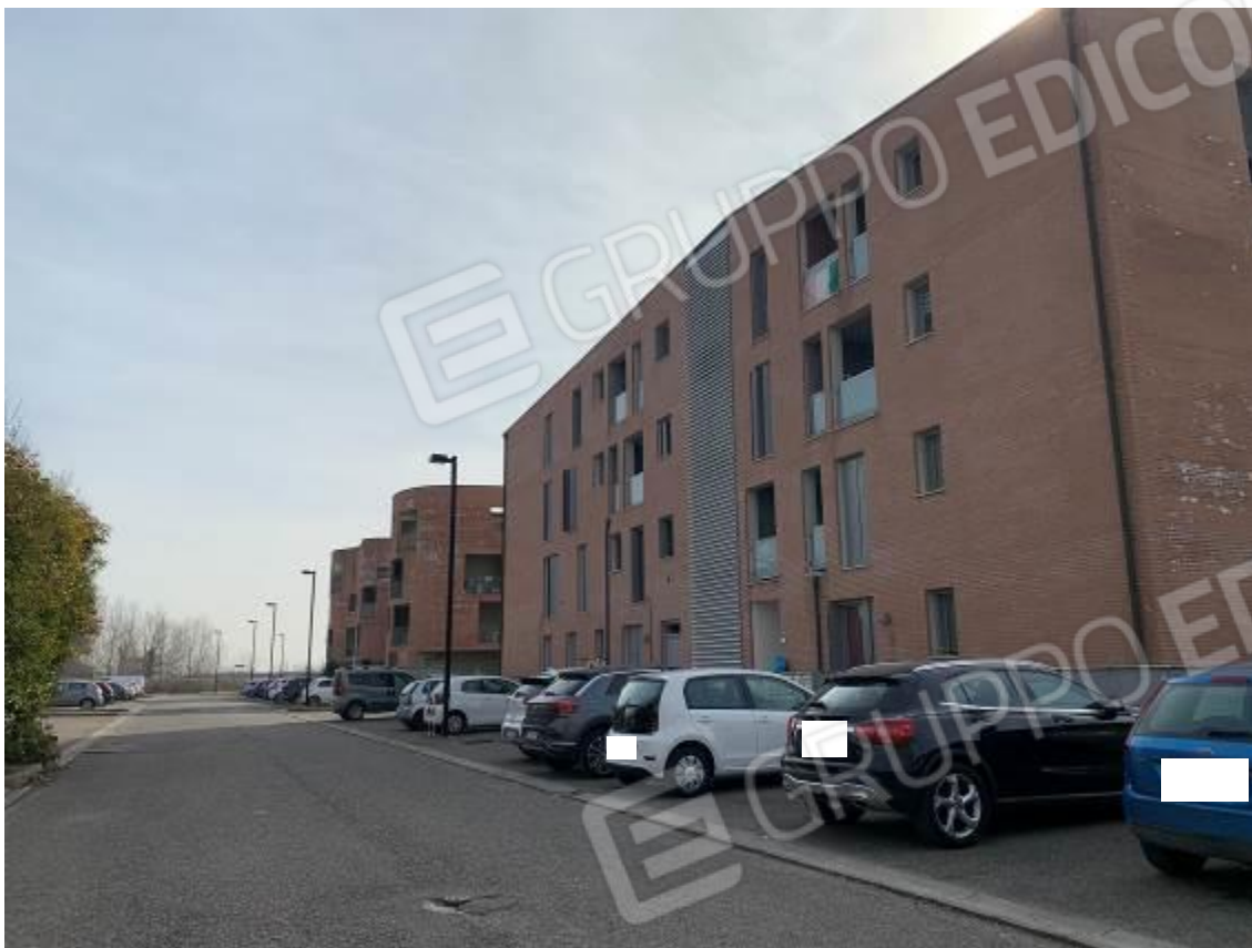
Foto 5: Esterni – Fabbricato B
