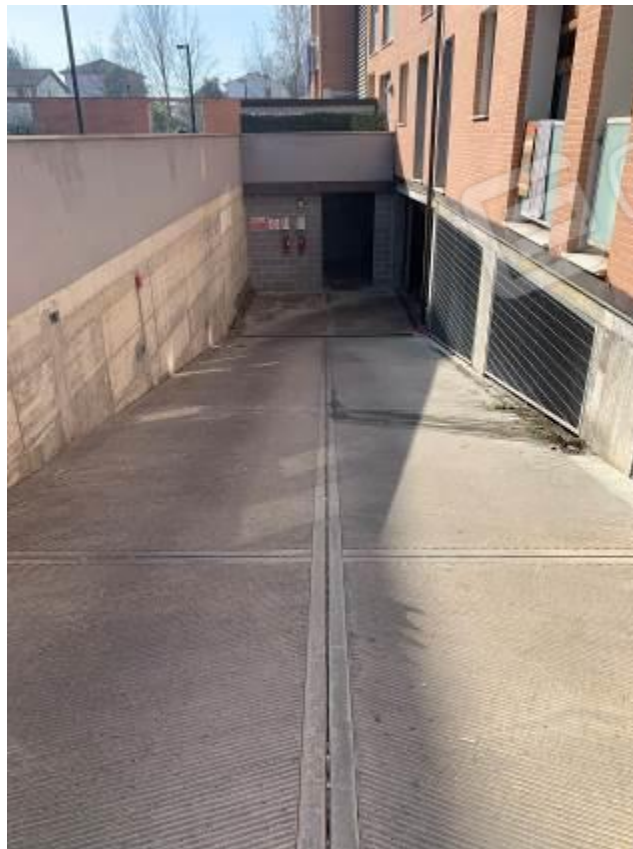
Foto 31: Accesso ai garage – Fabbricato B
