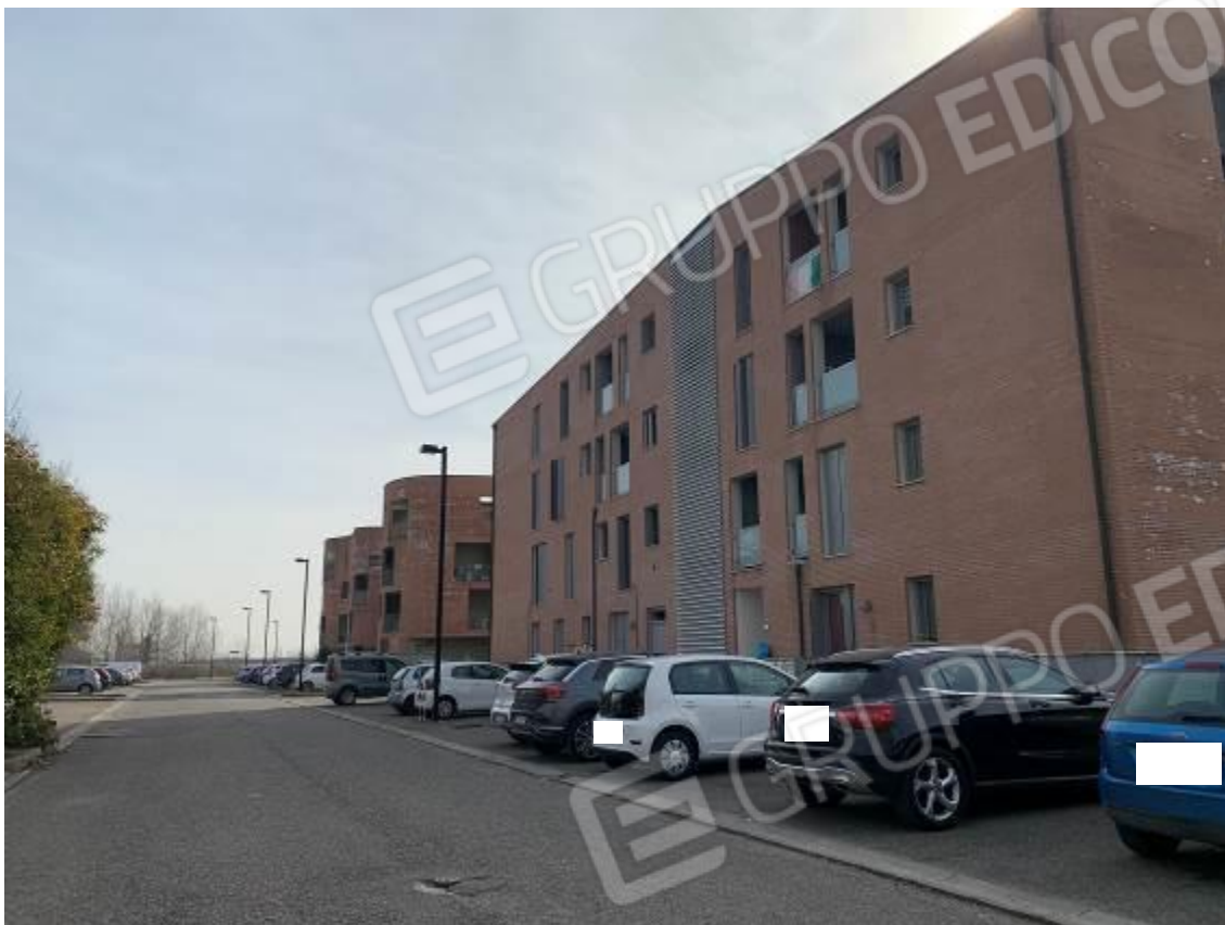
Foto 5: Esterni – Fabbricato B
