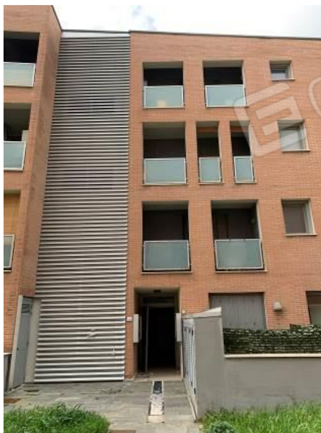
Foto 6: Esterni – Fabbricato B
