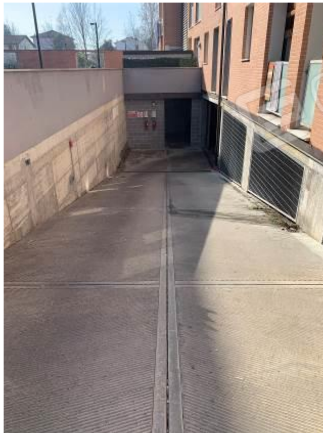
Foto 31: Accesso ai garage – Fabbricato B
