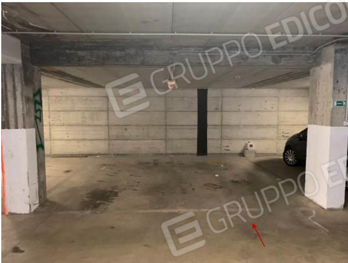
Foto 34: Parcheggio coperto, subalterno 103
