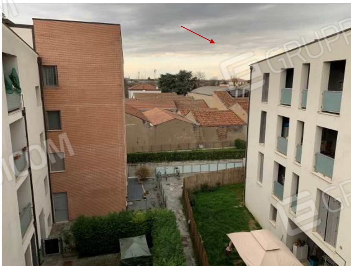
Foto 10: Esterni – Fabbricato B
