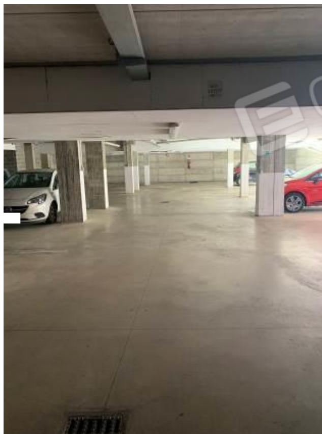
Foto 31: Passaggio carrabile comune – Fabbricato B
