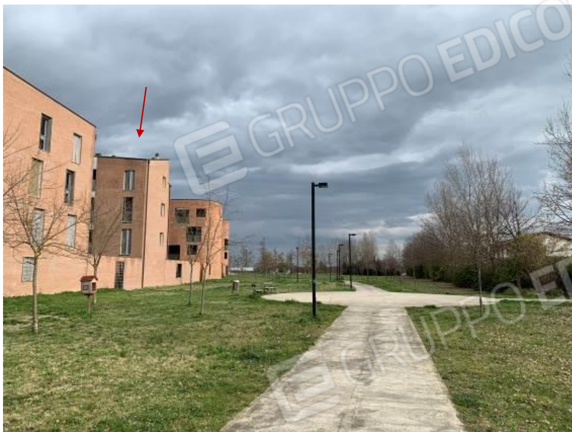
Foto 11: Esterni – area circostante
