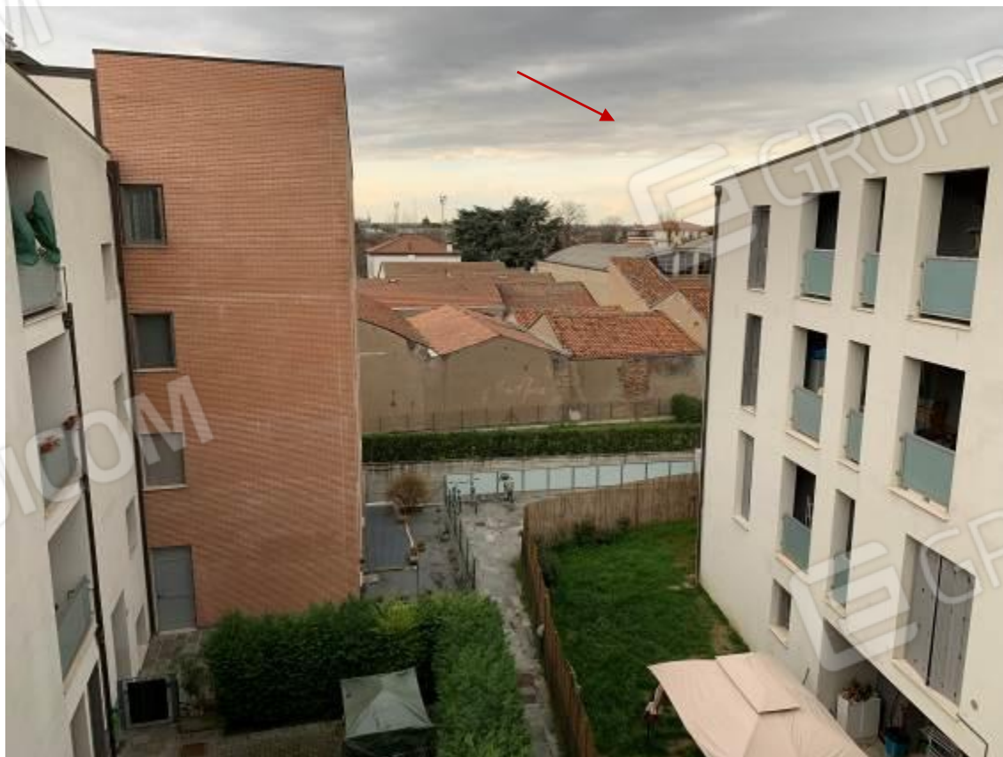
Foto 10: Esterni – Fabbricato B
