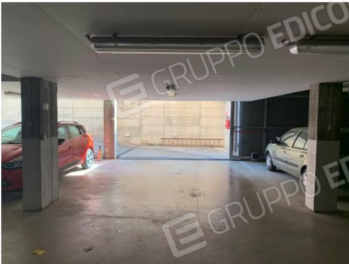
Foto 30: Passaggio carrabile comune – Fabbricato B
