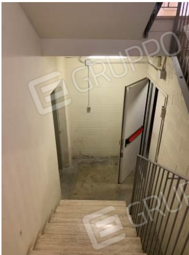
Foto 17: Parti comuni – Fabbricato B
