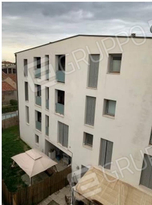
Foto 9: Esterni – Fabbricato B
