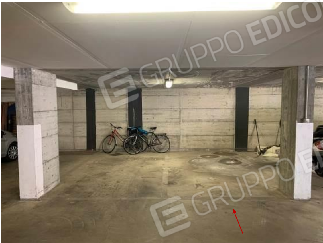
Foto 34: Parcheggio coperto, subalterno 114
