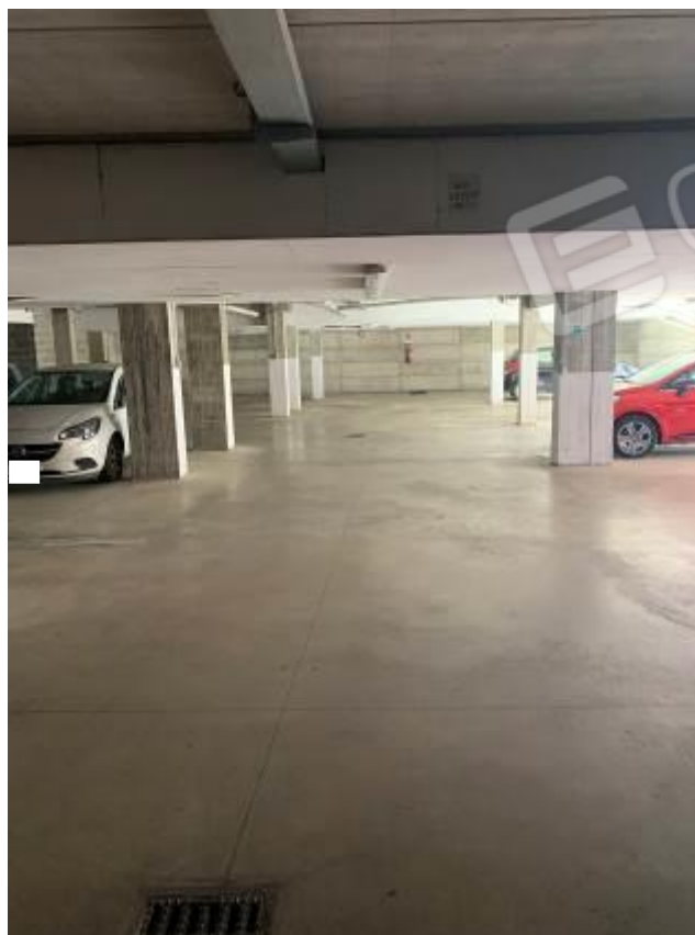
Foto 33: Passaggio carrabile comune – Fabbricato B
