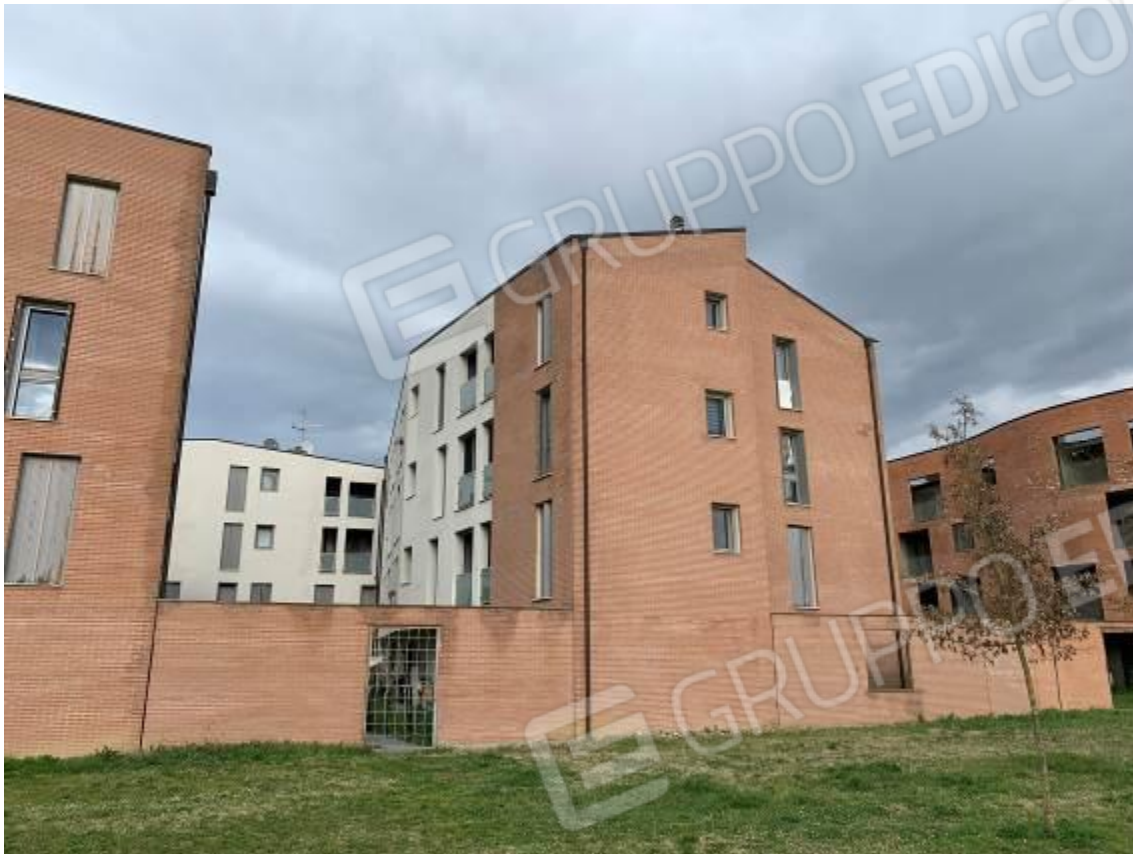
Foto 7: Esterni – Fabbricato B
