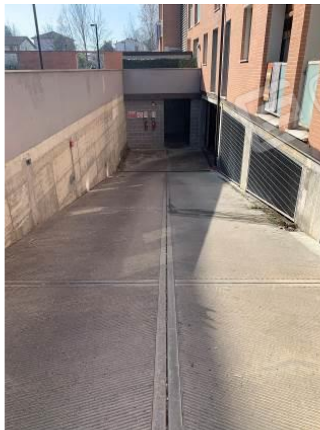
Foto 31: Accesso ai garage – Fabbricato B
