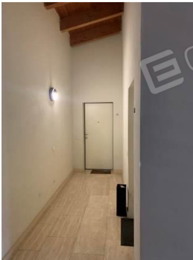
Foto 18: Parti comuni – Fabbricato B
