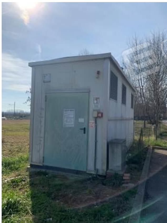
Foto 35: Centrale di teleriscaldamento
