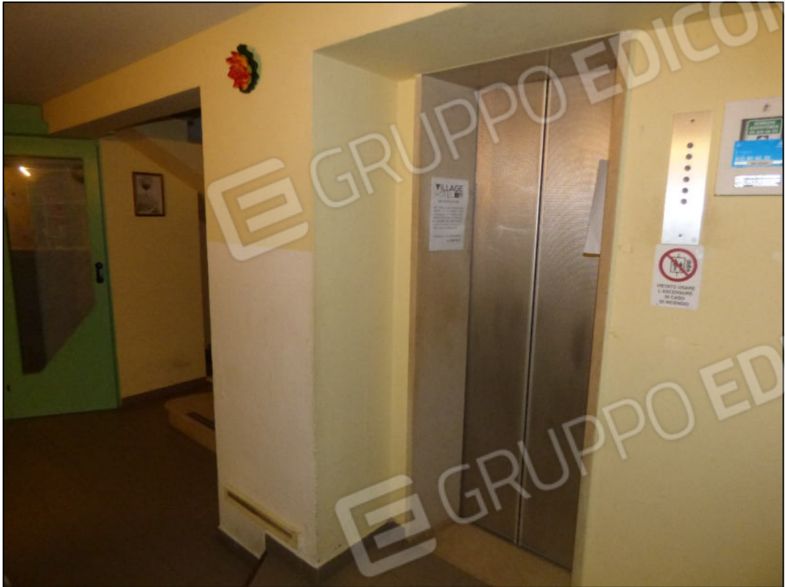
Fotografia 10_Vista del vano ascensore.
