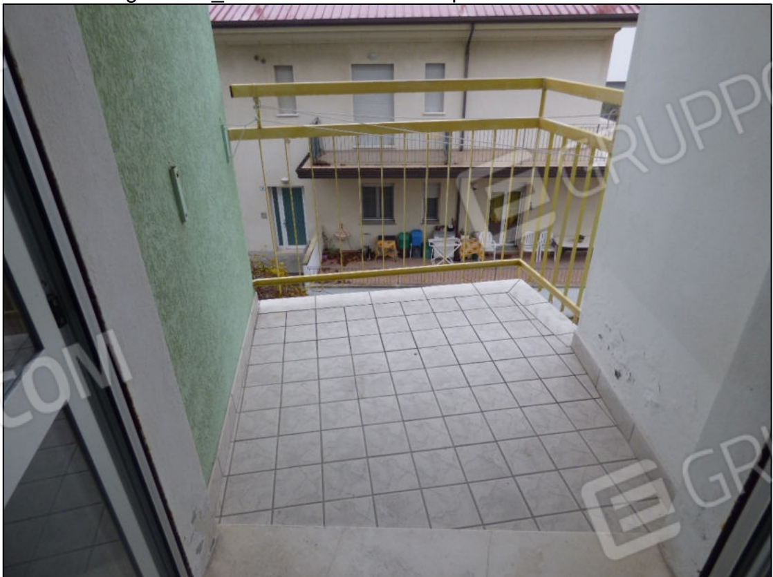
Fotografia 31_ Altra vista di balcone tipo annesso alle camere.
