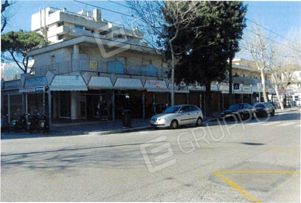
fronte intero complesso edilizio
