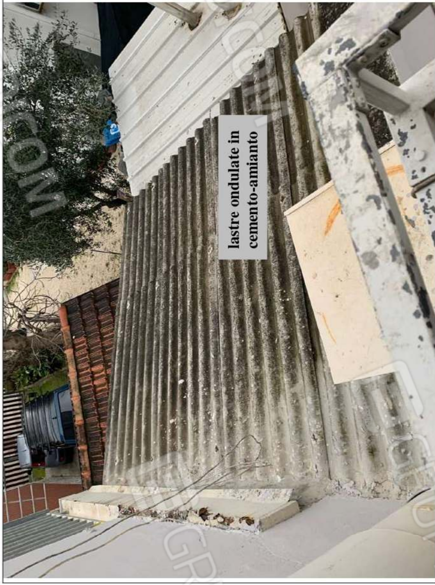
- IMMAGINE N. 31 - (particolare copertura piano rialzato)
