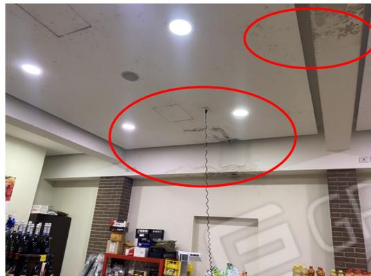
Foto 11: Magazzino 1\_Particolare infiltrazioni
