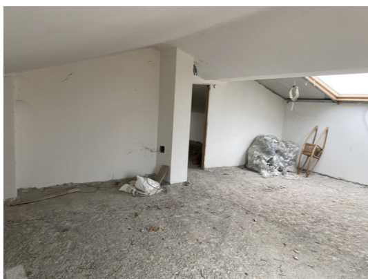
Foto 8: Ripostiglio al grezzo_P.Sottotetto
