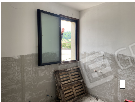
Foto 6: Bagno al grezzo_P1
