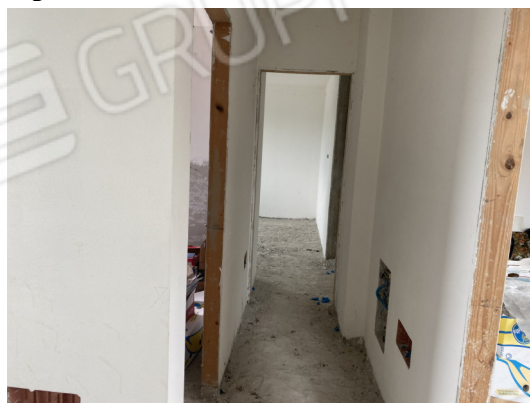
Foto 3: Disimpegno al grezzo_P1
