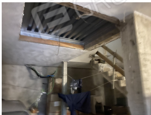
Foto 11: Autorimessa_PS1- Sacla BCNC al grezzo
