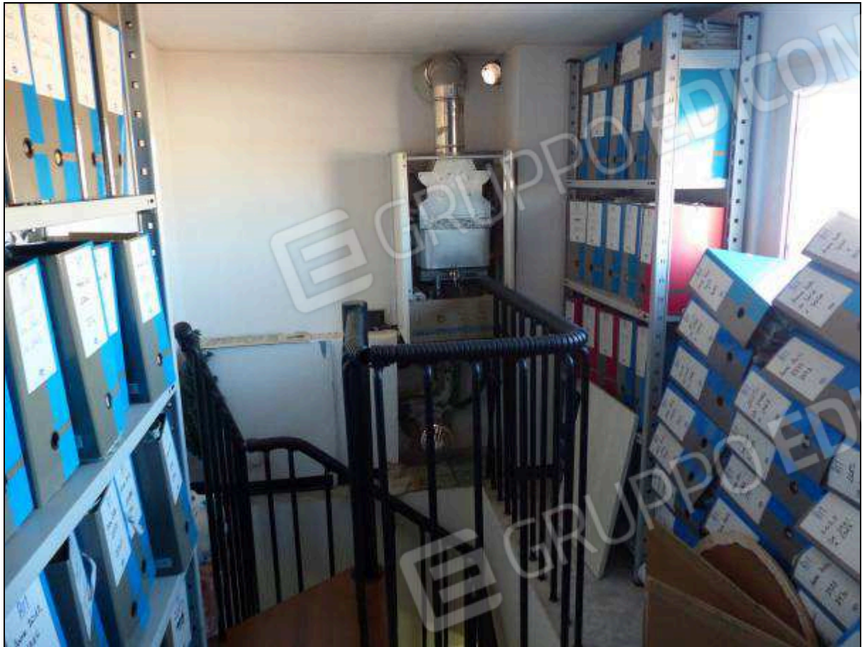
FOTO 37 – Piano terzo: ripostiglio, non supportato dai necessari titoli edilizi, da assoggettare a demolizione.
