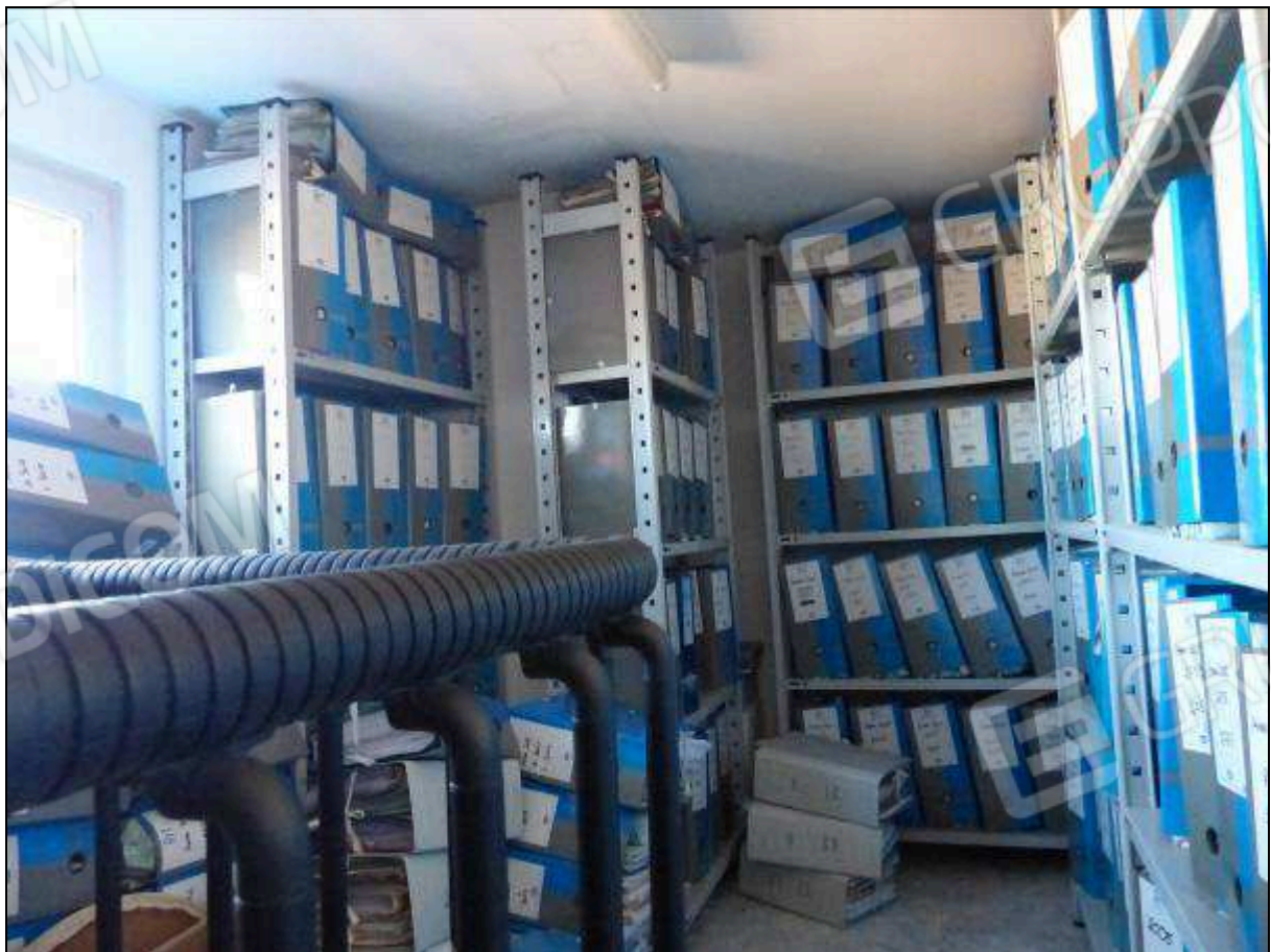
FOTO 38 – Piano terzo: ripostiglio, non supportato dai necessari titoli edilizi, da assoggettare a demolizione.
