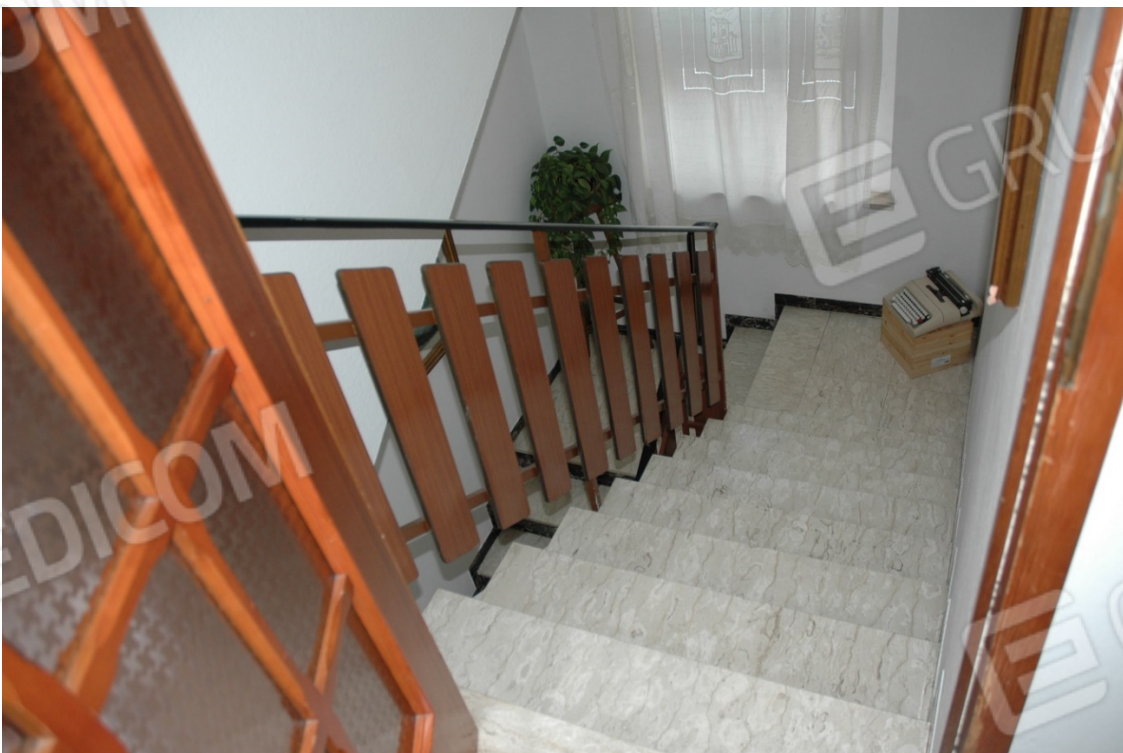
Vano scala con gradini in marmo
