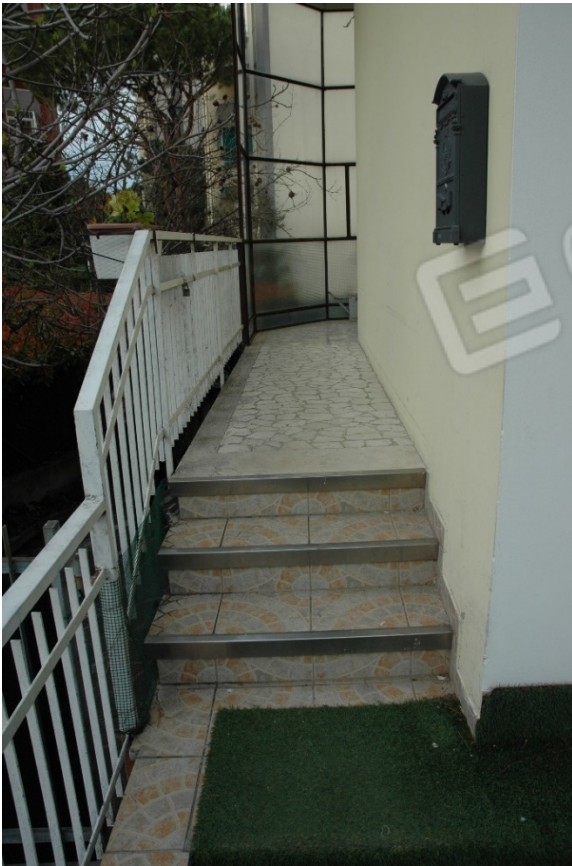
Gradini di accesso al pianerottolo del vano scala
