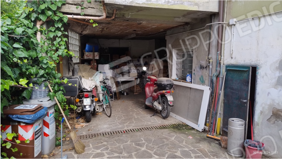
Portico (sub.9) con ingresso al deposito (sub. 9 e 7).
