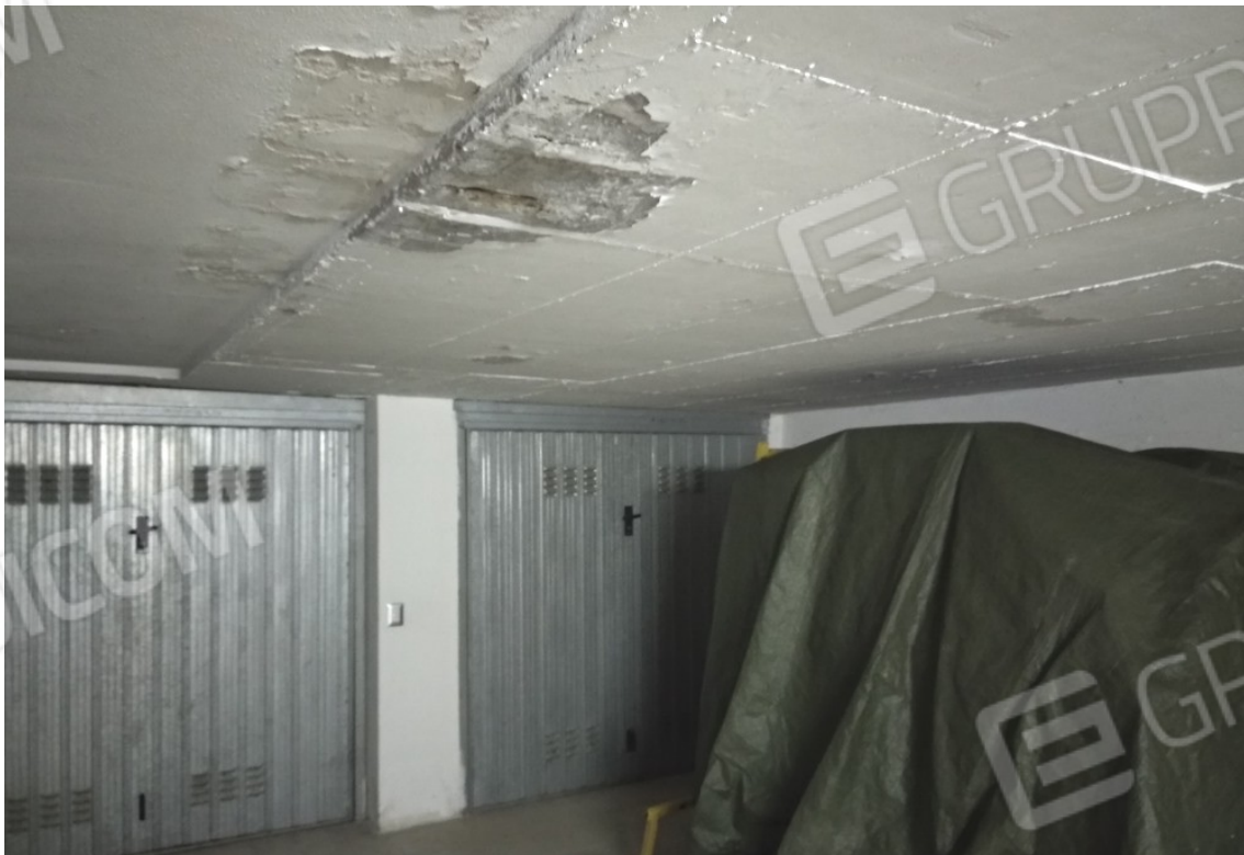
FOTO 13 – piano interrato – corsia manovra comune
