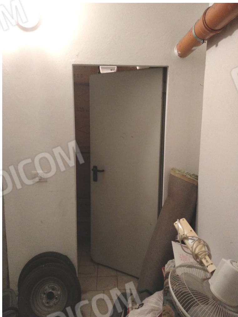
FOTO 15 piano interrato cantina
