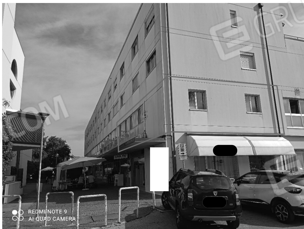
Vista angolo Nord – Ovest / Sud - Ovest
