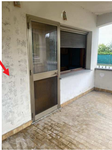
particolare prospetti esterni con degrado delle pitture
