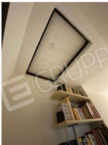
vista botola di accesso alla soffitta collocata nel corridoio
