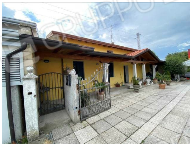
vista portico abusivo
