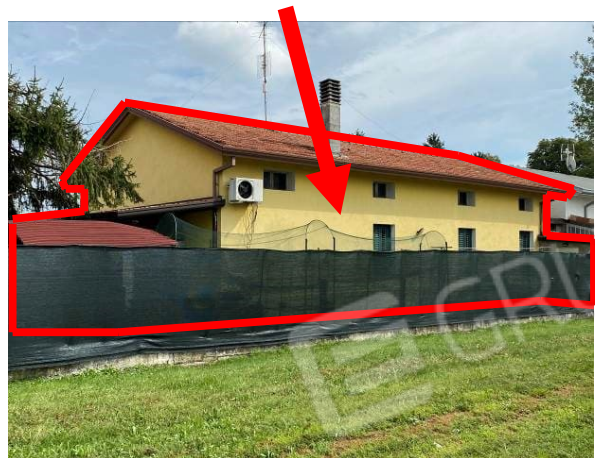
vista prospetto lato ovest abitazione
