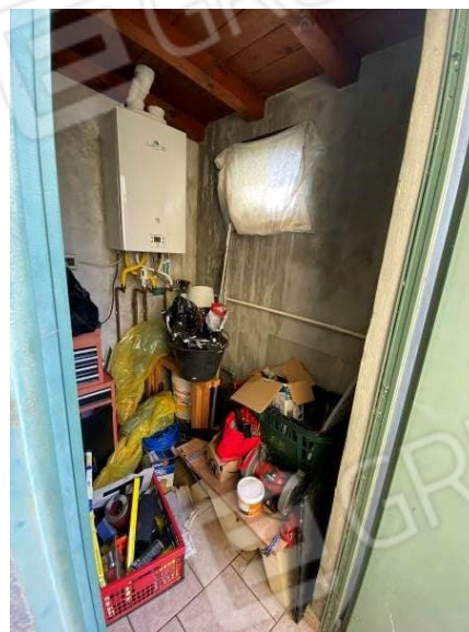
vista interna ripostiglio/centrale termica
