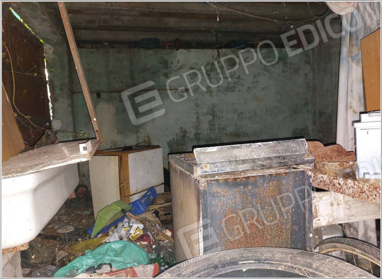
Foto n° 25 - Comune di Annone Veneto, foglio 1, part.811, sub.3 – Stanza catastalmente identificata come magazzino.
