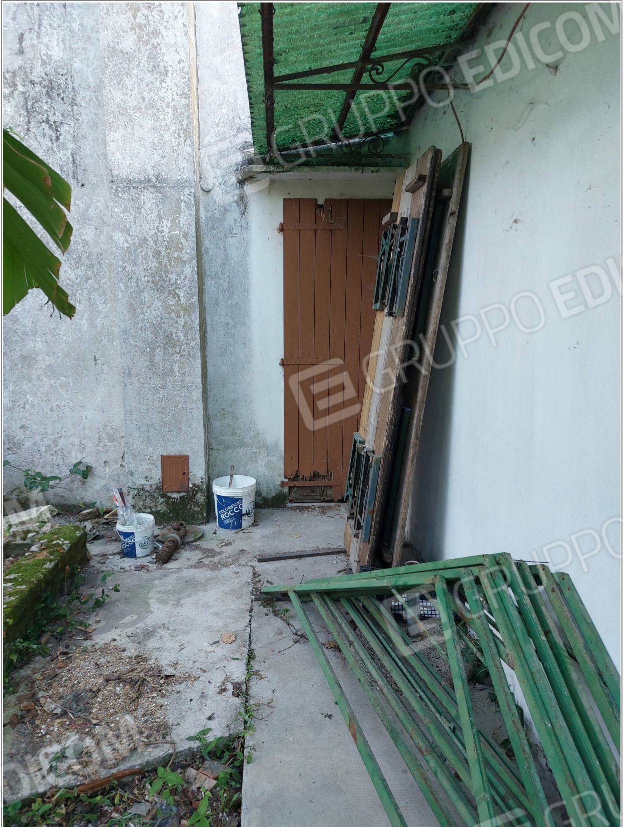
Foto n° 22 - Comune di Annone Veneto, foglio 1, part.1032 – Corte. Visibile la porta di accesso secondaria, che immette nella cucina.
