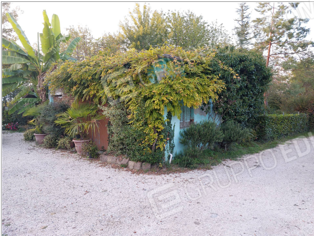
Foto n° 23 - Comune di Annone Veneto, foglio 1, part.811, sub.3 – Visione esterna del fabbricato pignorato.
