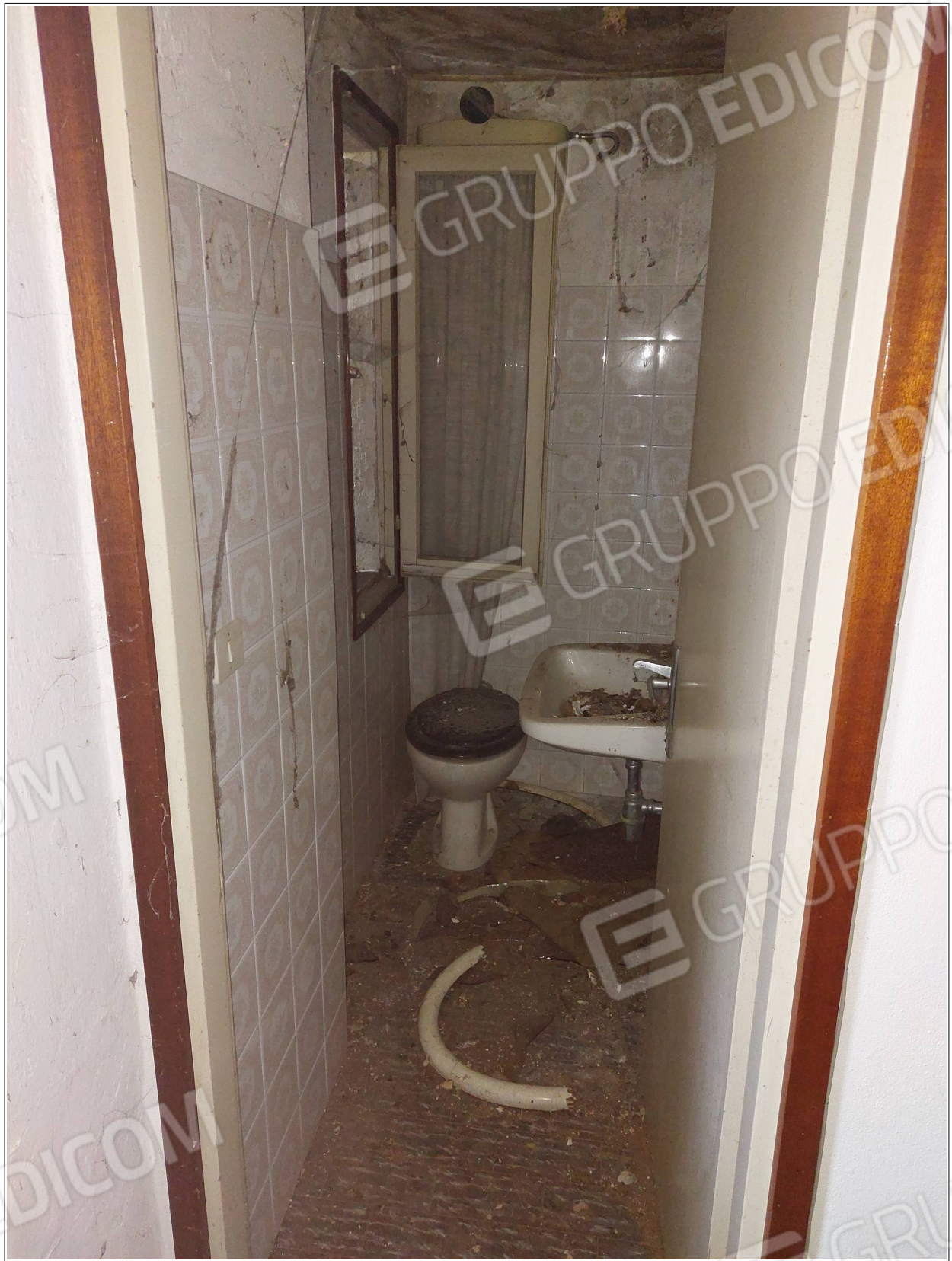
Foto n° 13 - Comune di Annone Veneto, foglio 1, part.1032 – Piano primo. Bagno.
