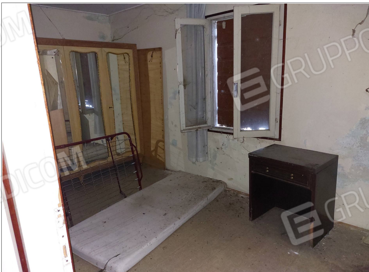
Foto n° 17 - Comune di Annone Veneto, foglio 1, part.1032 – Piano secondo. Stireria.
