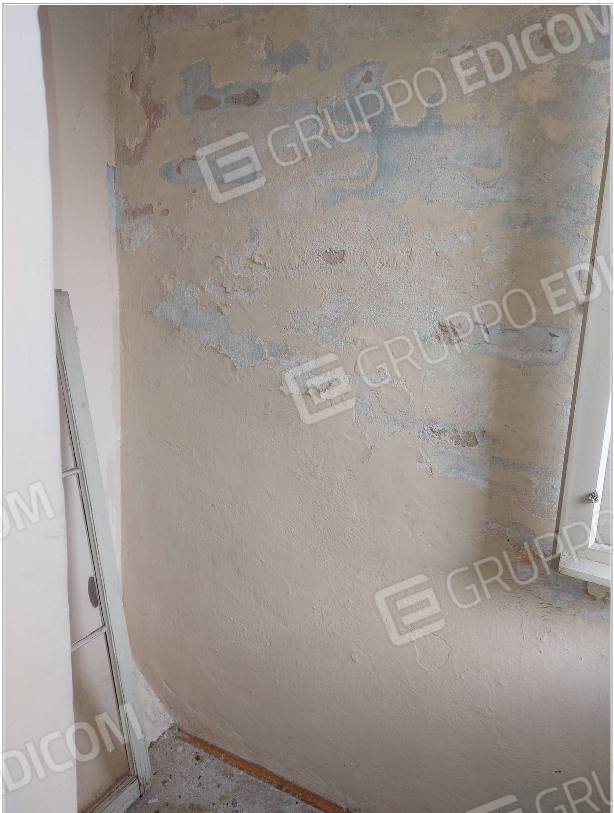
Foto n° 18 - Comune di Annone Veneto, foglio 1, part.1032 – Piano secondo. Camera.
