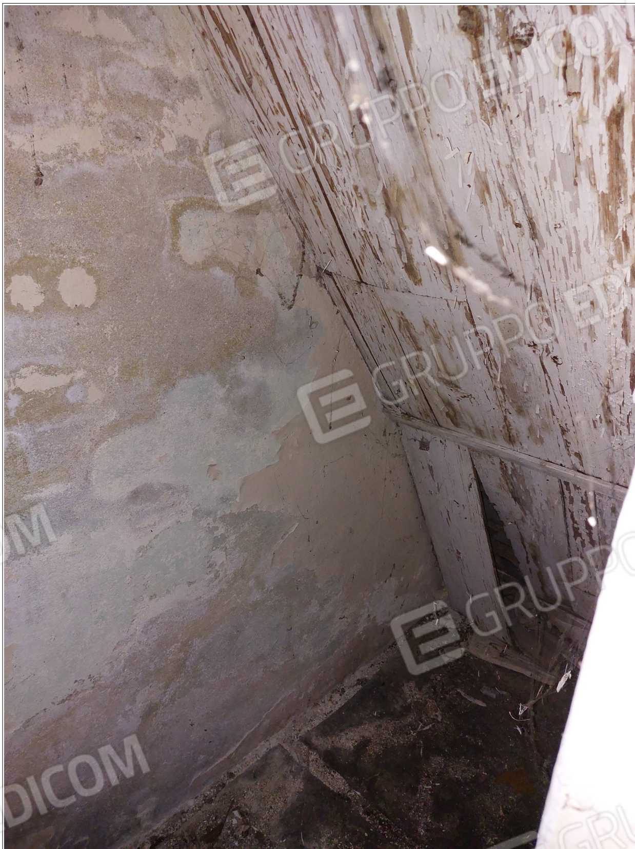
Foto n° 19 - Comune di Annone Veneto, foglio 1, part.1032 – Piano secondo. Sottoscala accessibile dalla stireria.
