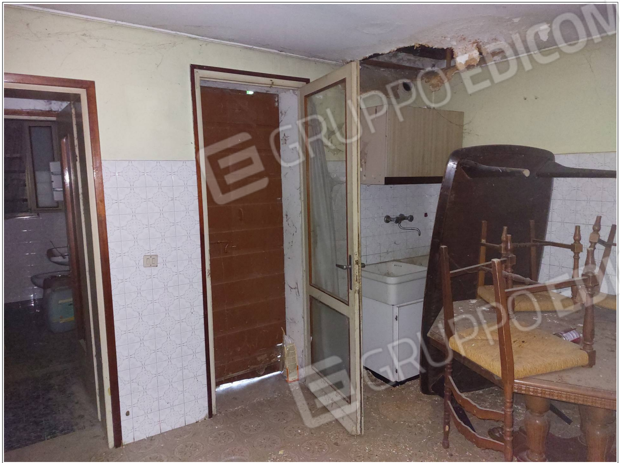
Foto n° 5 - Comune di Annone Veneto, foglio 1, part.1032 – Piano terra. Cucina.
