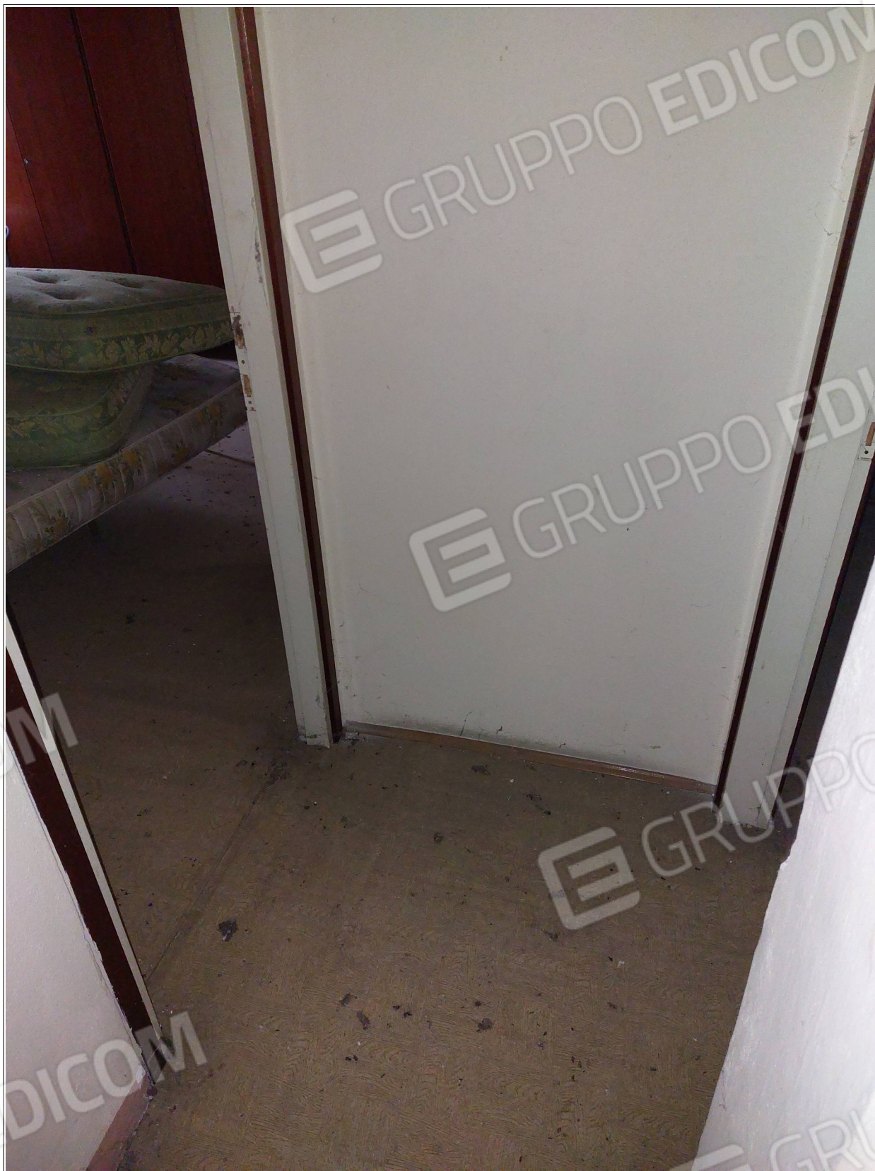
Foto n° 15 - Comune di Annone Veneto, foglio 1, part.1032 – Piano secondo. Corridoio.
