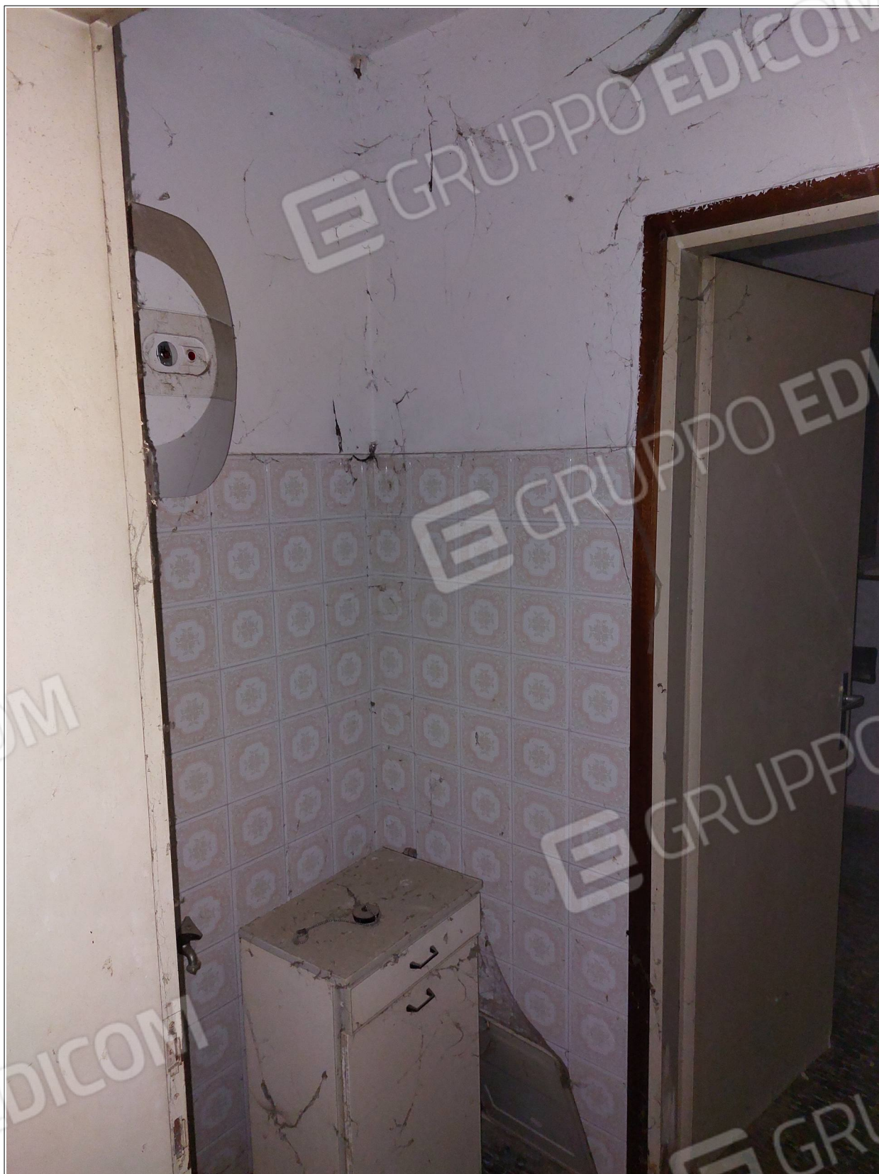
Foto n° 8 - Comune di Annone Veneto, foglio 1, part.1032 – Piano terra. Antibagno.
