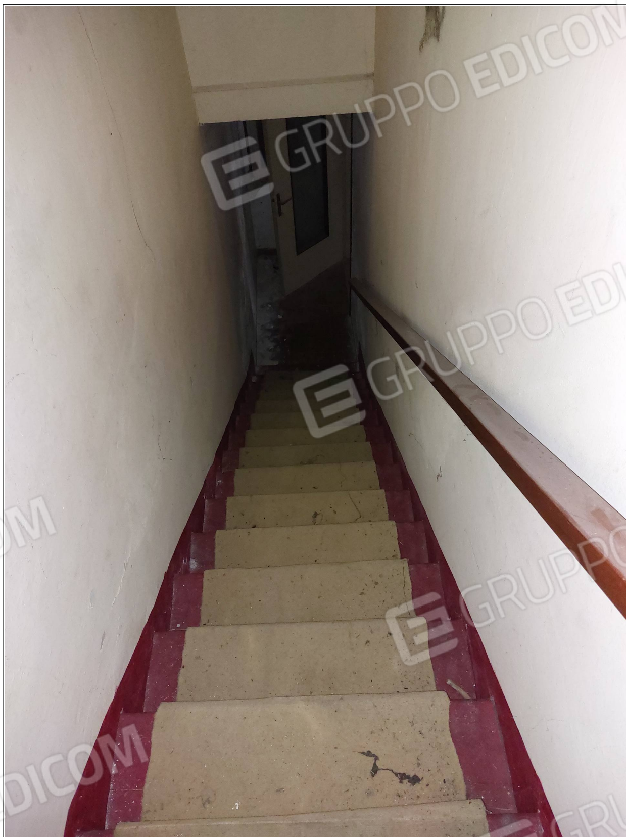
Foto n° 10 - Comune di Annone Veneto, foglio 1, part.1032 – Scale interne.
