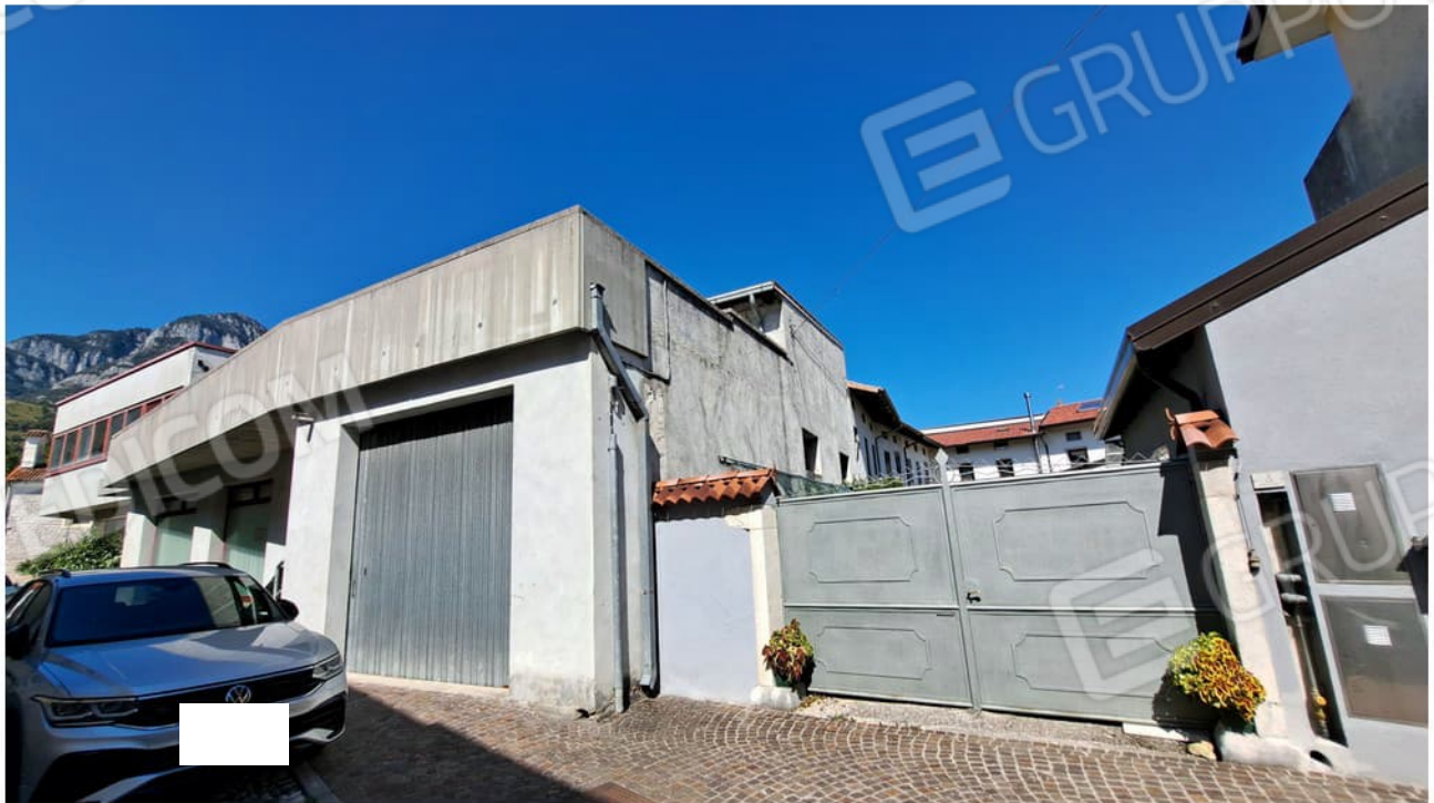
6 - via manin lato confine
