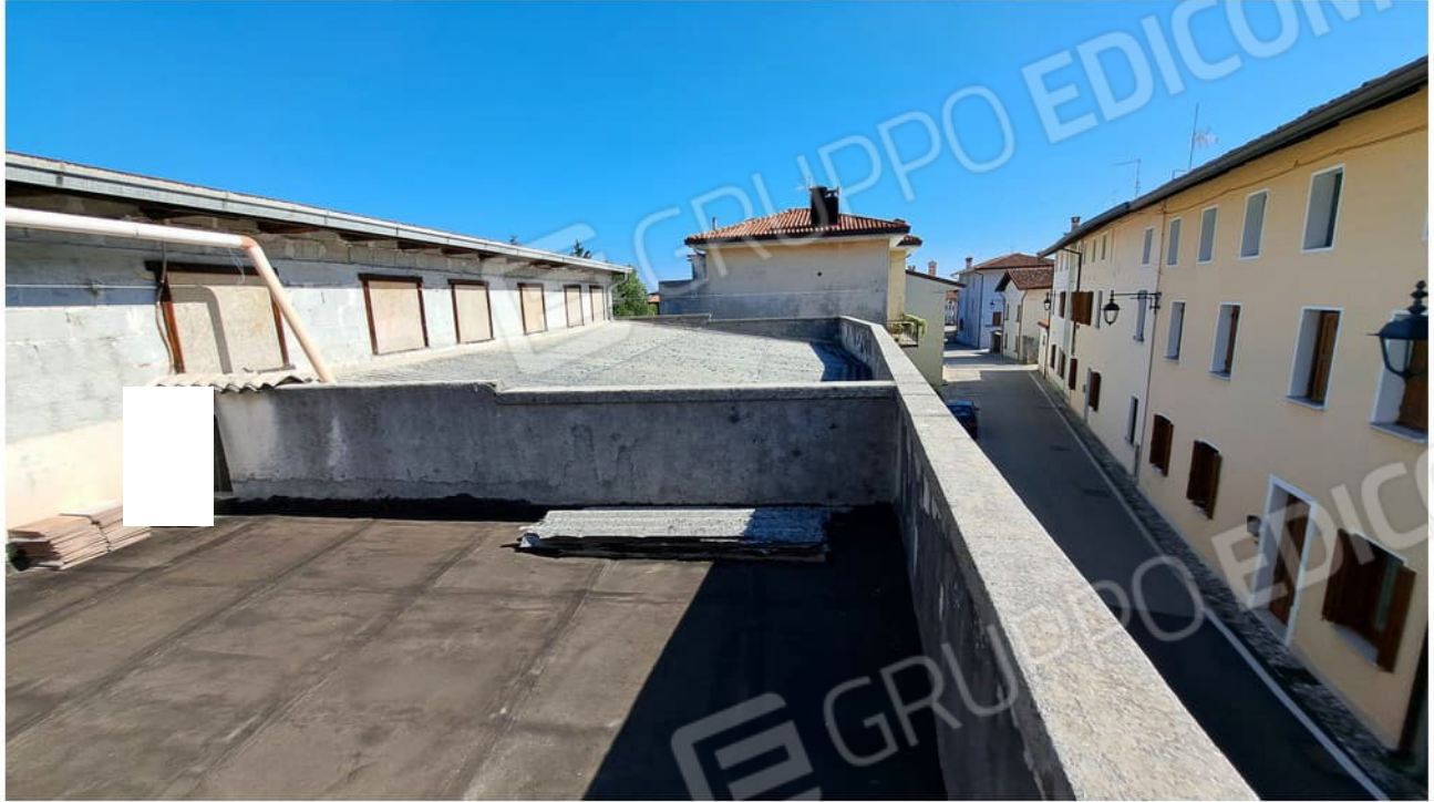
43 - terrazzo copertura p1
