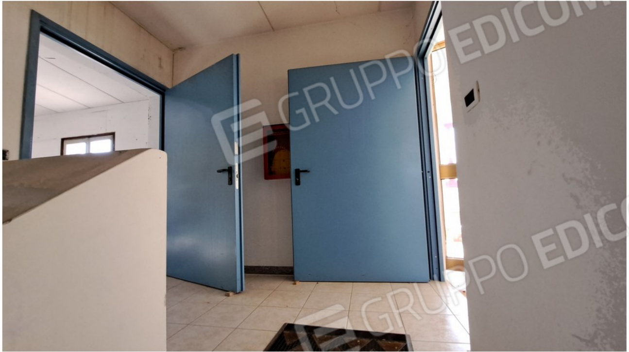
33 - vano scala disimpegno piano primo
