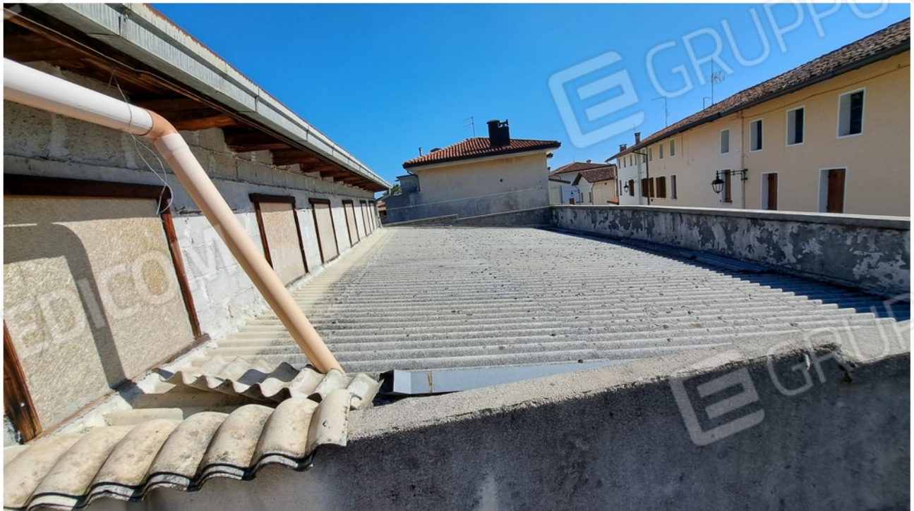
46 - copertura bassa particolare
