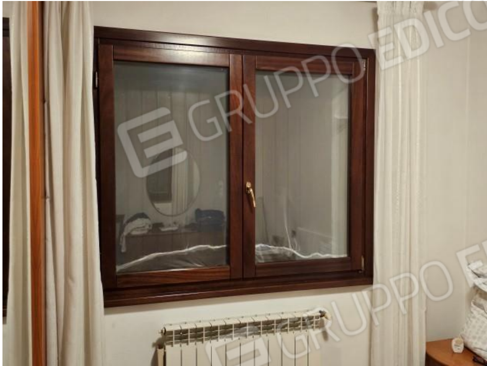
FOTO 17: SERRAMENTO (SUB. 4 – 1°P.)
