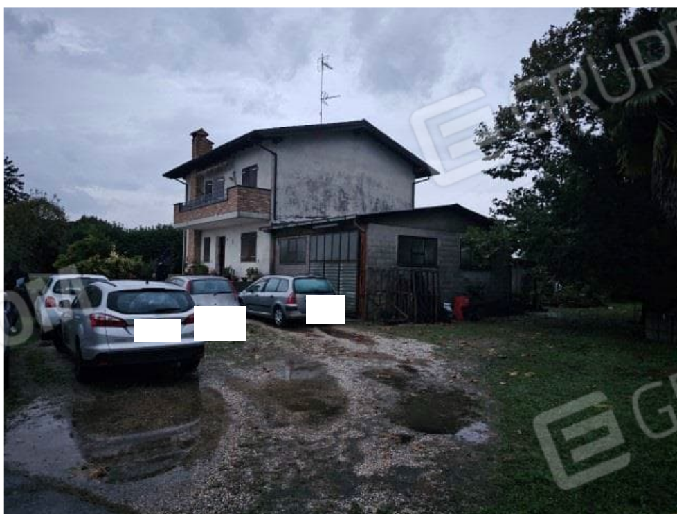
FOTO 2: ALTRA PANORAMICA DEL FABBRICATO
