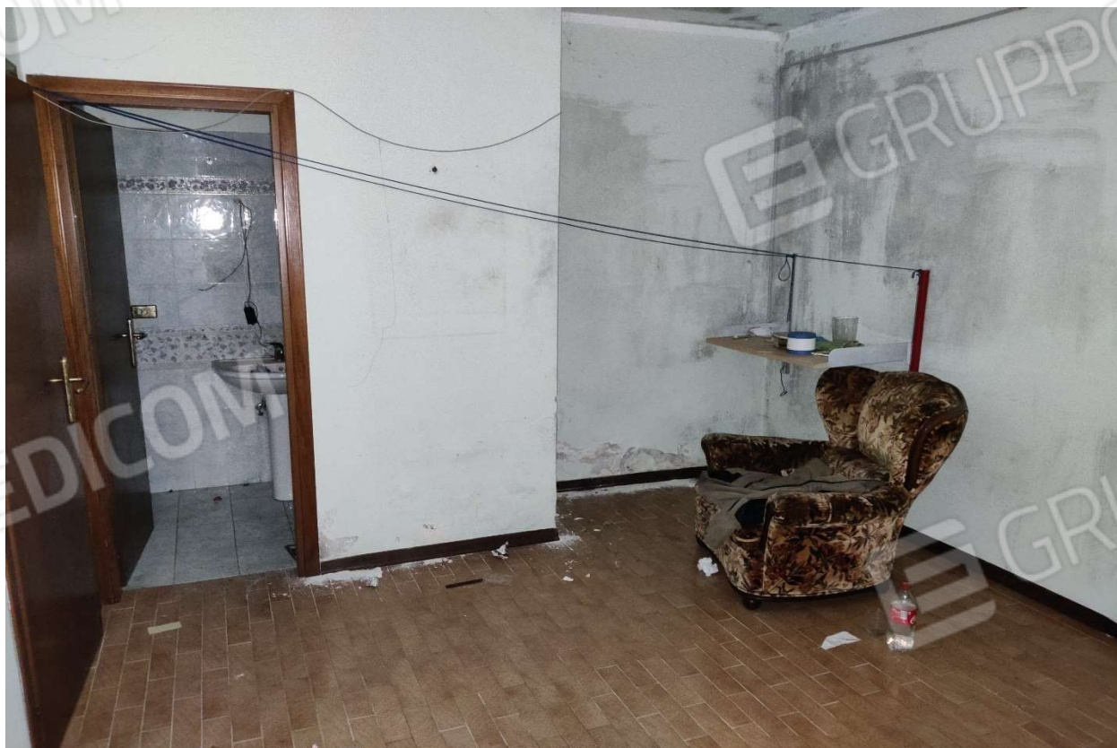
Foto n. 18 - Camera con servizi igienici.
