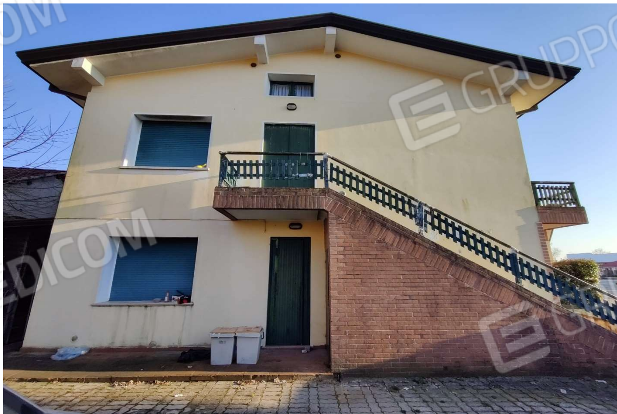
Foto n. 4 - Facciata Nord vista dal cortile interno.
