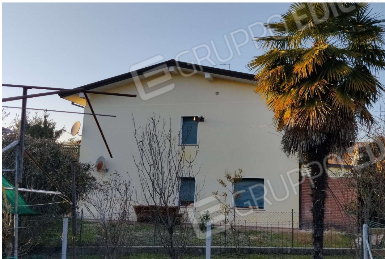
Foto n. 3 - Abitazione vista da altra proprietà (facciata rivolta a Sud).
