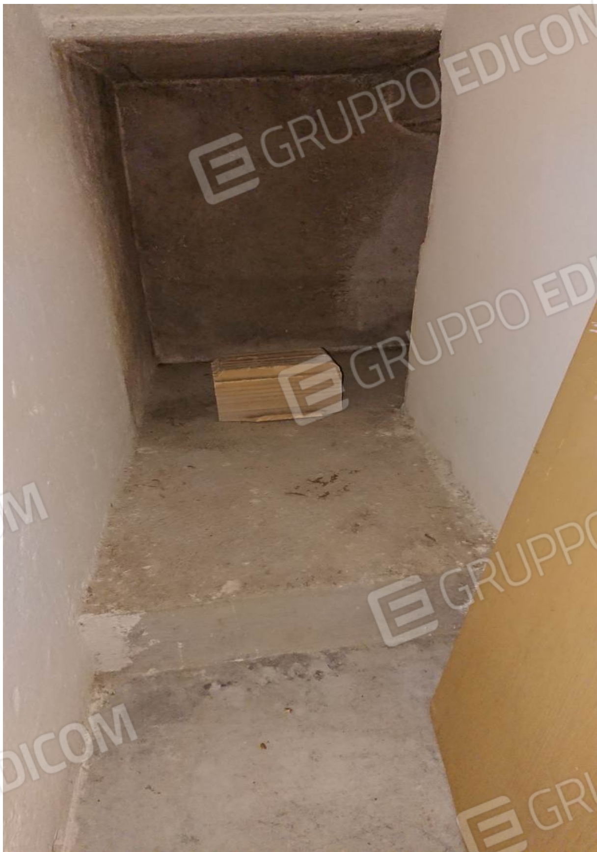
Foto n° 5 - 18/01/2022 - Comune di Caneva, foglio 21, part.156-157 – Sottoscala adiacente al vano catastalmente identificato come "secchiaio"
