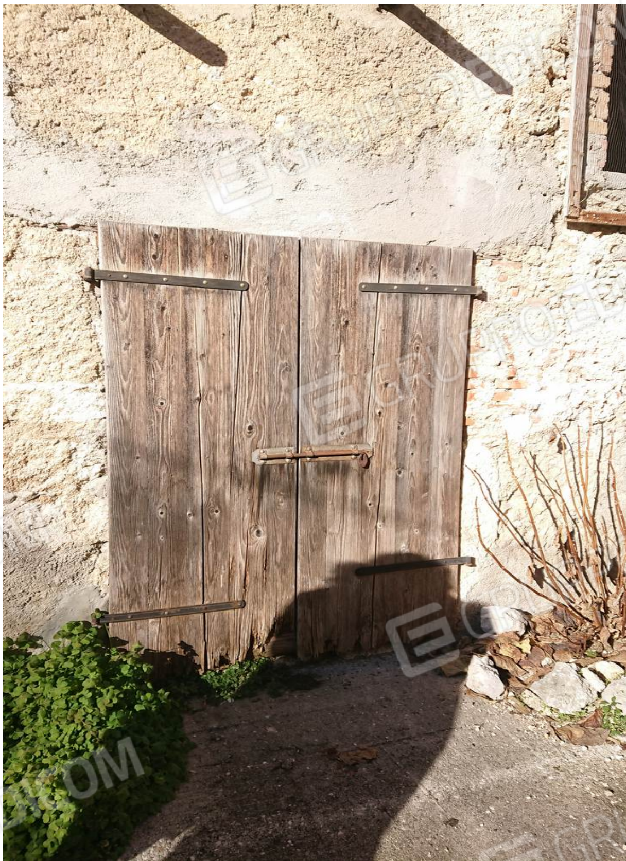
Foto n° 24 - 18/01/2022 - Comune di Caneva, foglio 21, part.159 – Portone di accesso.
