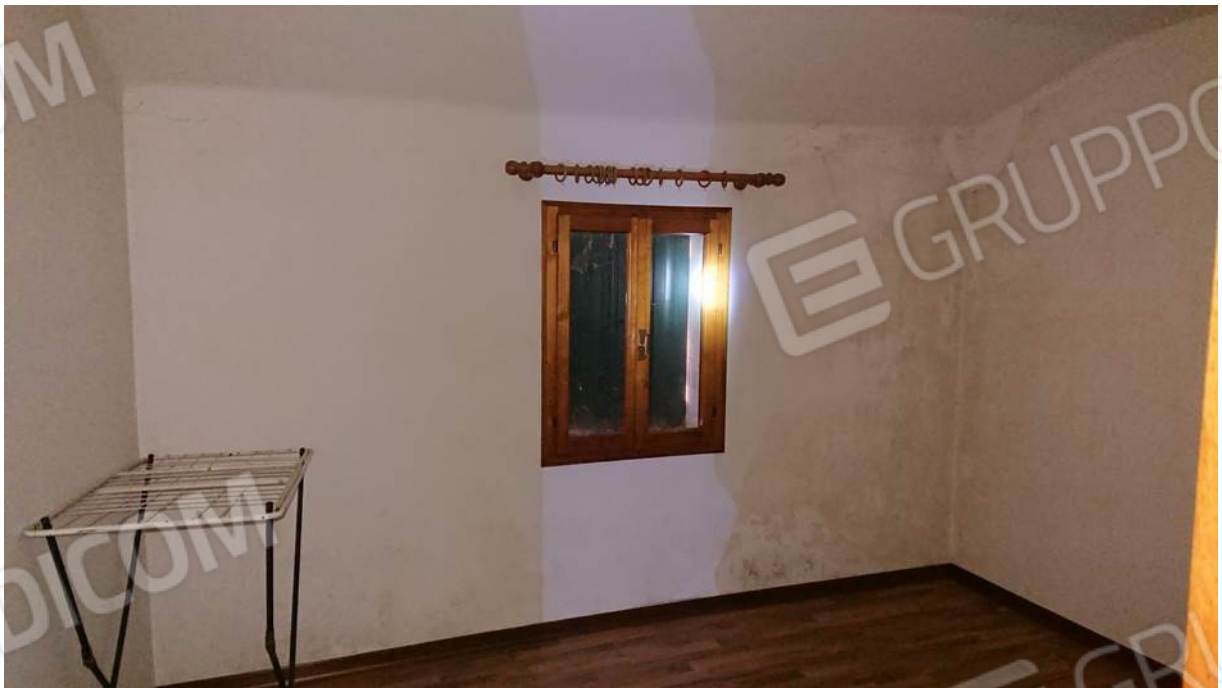
Foto n° 17 - 18/01/2022 - Comune di Caneva, foglio 21, part.156-157 – Camera.
