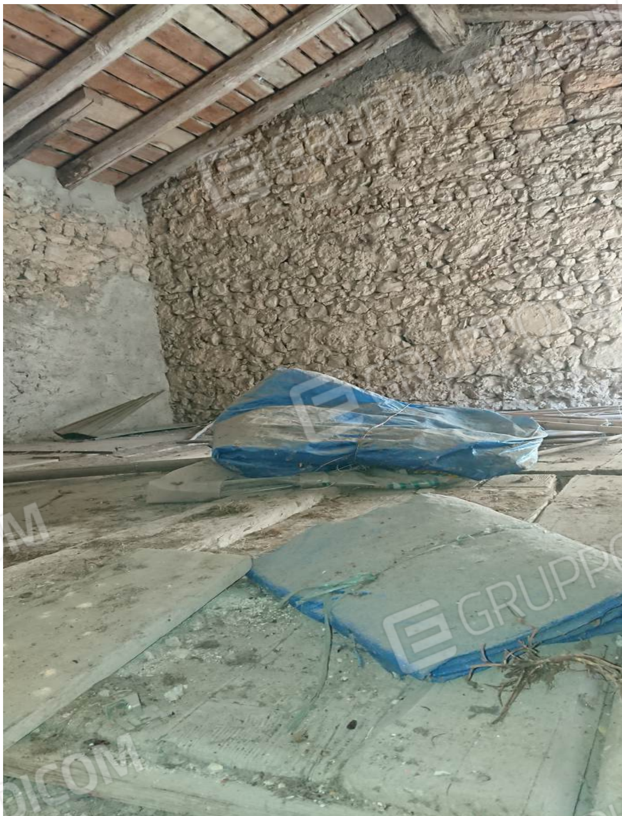
Foto n° 27 - 18/01/2022 - Comune di Caneva, foglio 21, part.159 – Piano primo.
