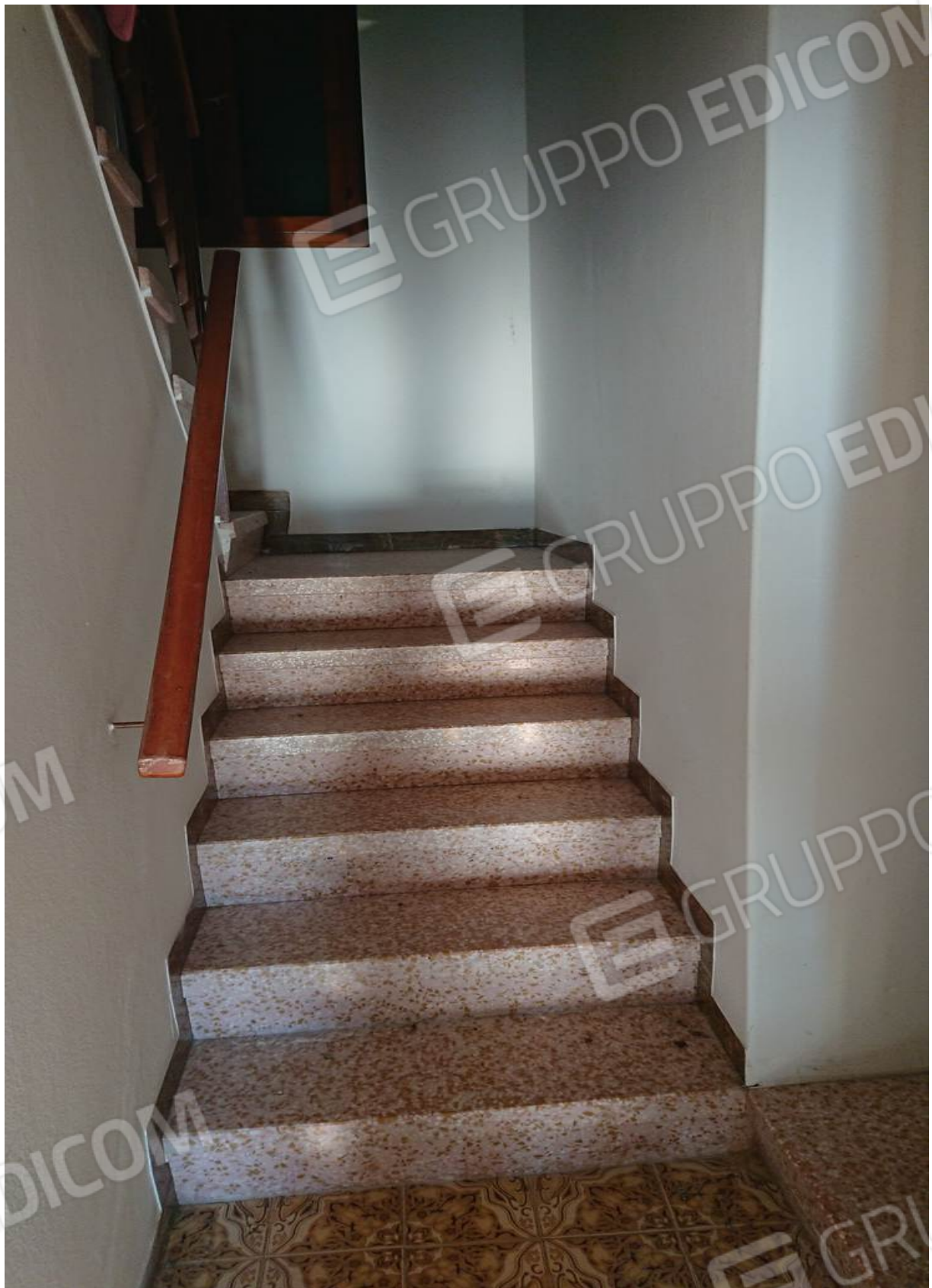
Foto n° 10 - 18/01/2022 - Comune di Caneva, foglio 21, part.156-157 – Scale che conducono al primo piano.
