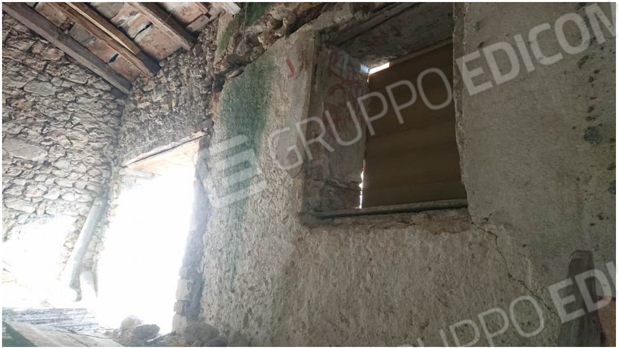
Foto n° 28 - 18/01/2022 - Comune di Caneva, foglio 21, part.159 – Piano primo.
