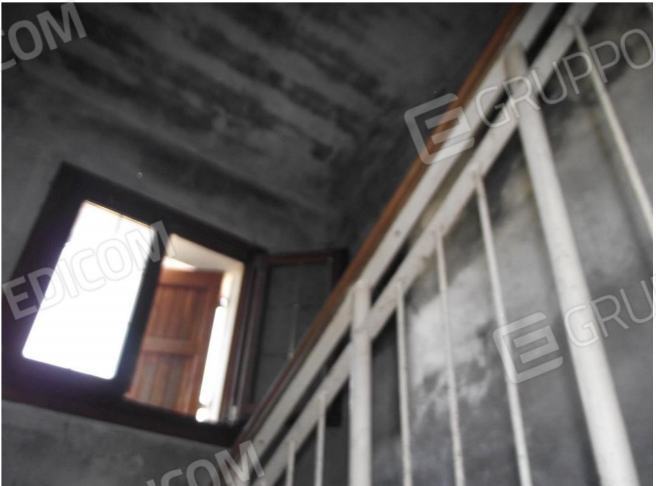
Foto 20 – lotto 2 - scala accesso soffitta
