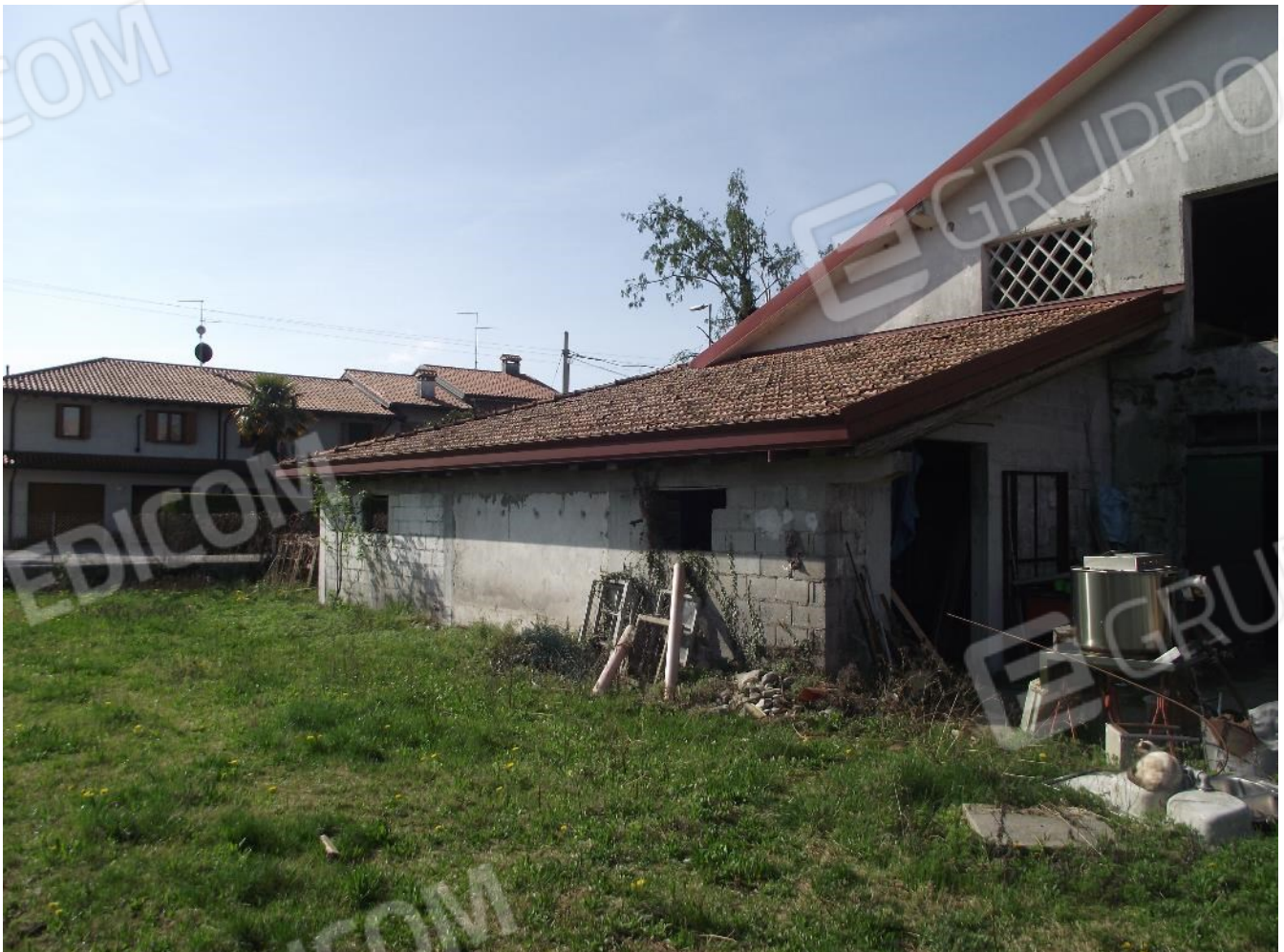
Foto 8 – lotto 2 stalla pollaio a ridosso dell'abitazione
