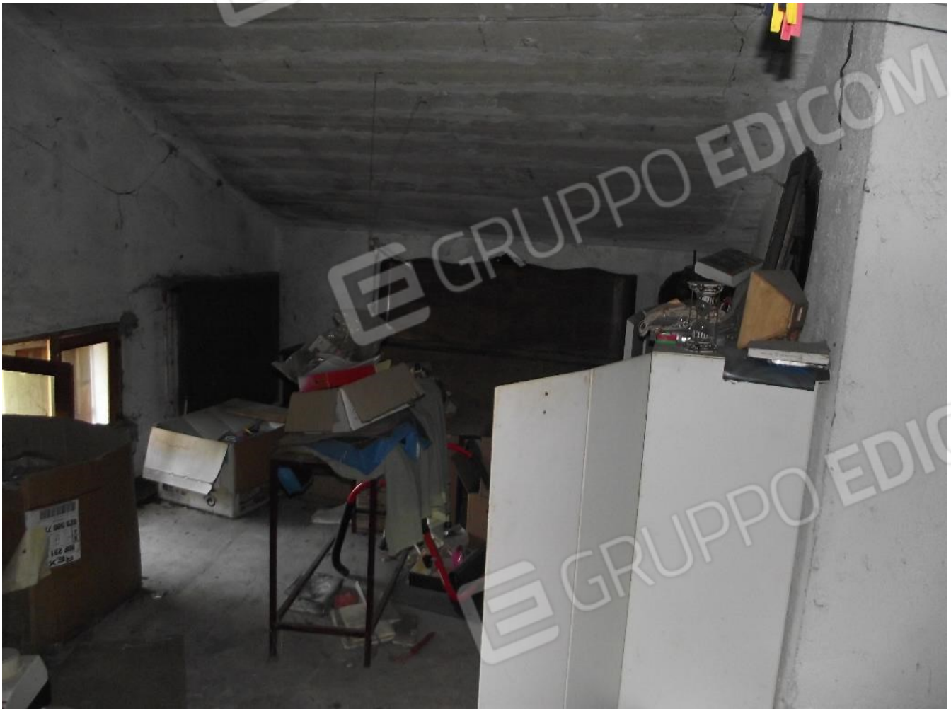
Foto 19 – lotto 2 – soffitta ex granaio
