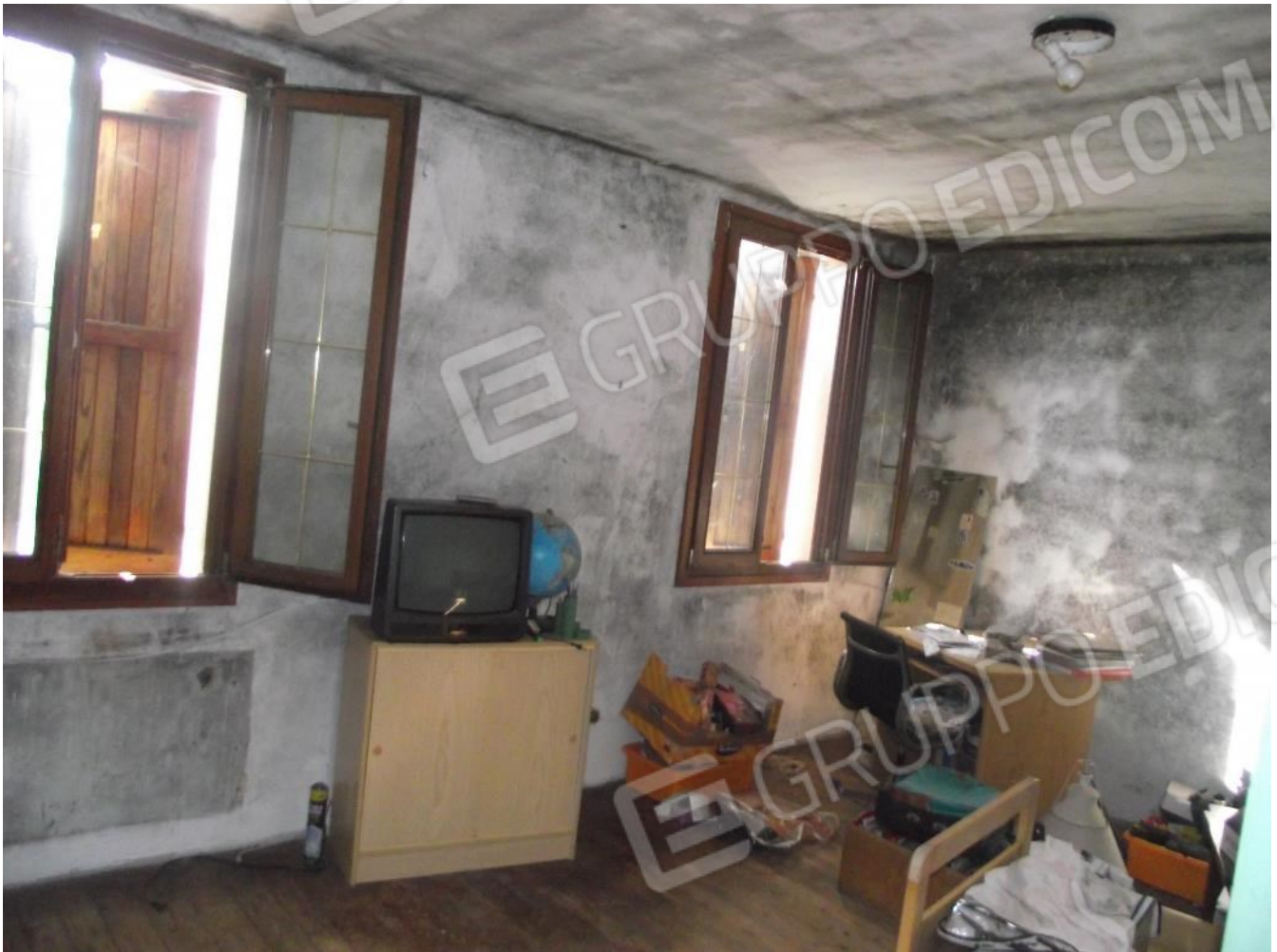
Foto 17 – lotto 2 - camera piano primo
