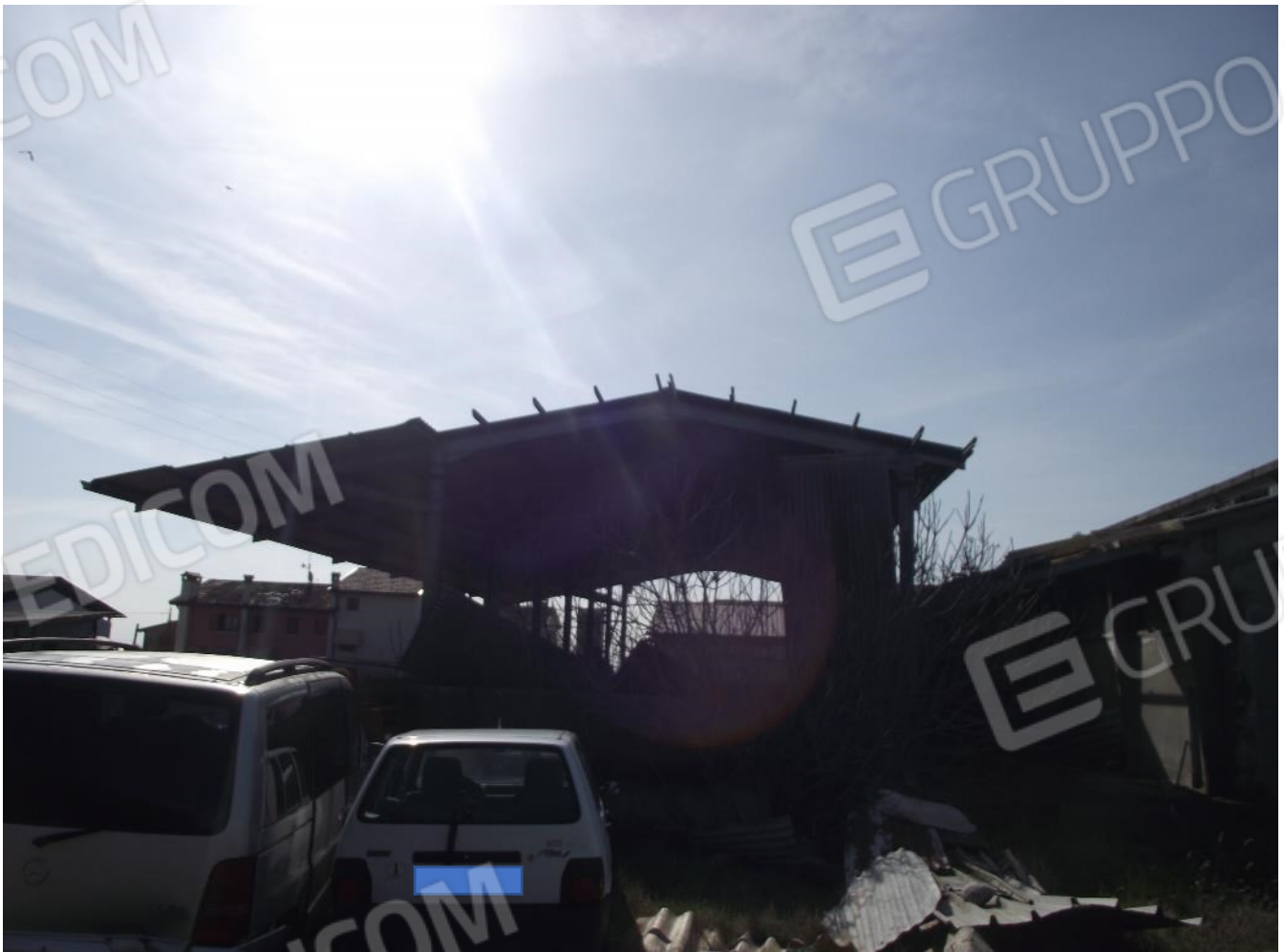
Foto 32 – lotto 2 – tettoia copertura concimaia
