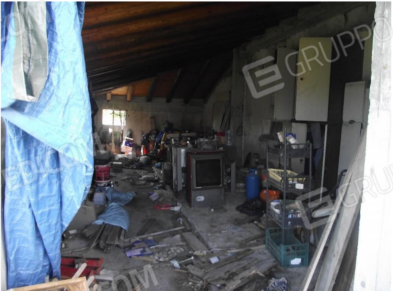
Foto 22 – lotto 2 – ex deposito adiacente all'abitazione
