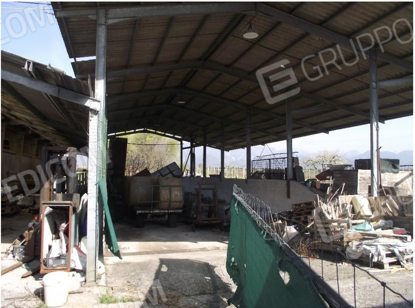
Foto 30 – lotto 2 – concimaia coperta
