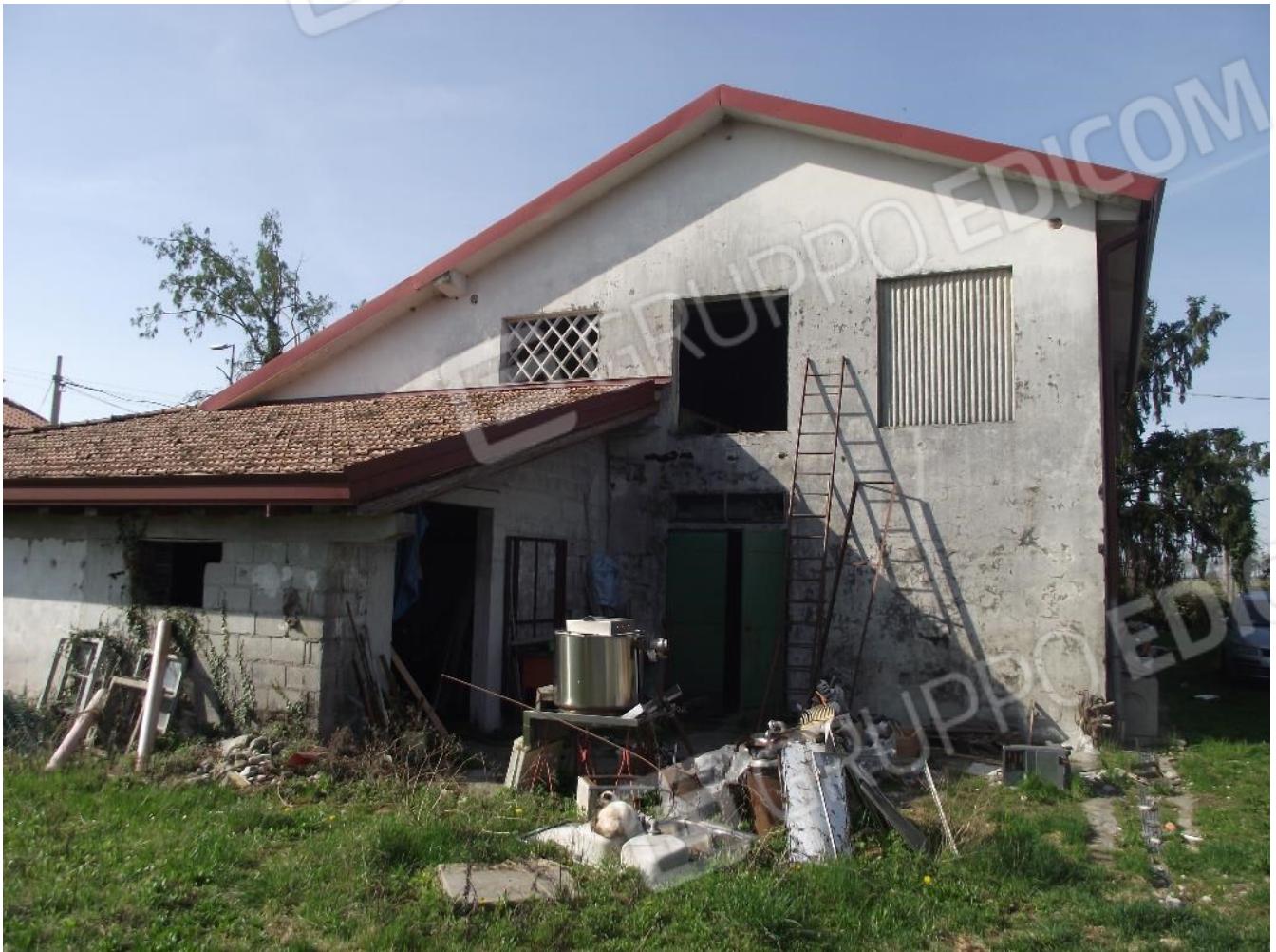
Foto 7 – lotto 2 stalla pollaio a ridosso dell'abitazione
