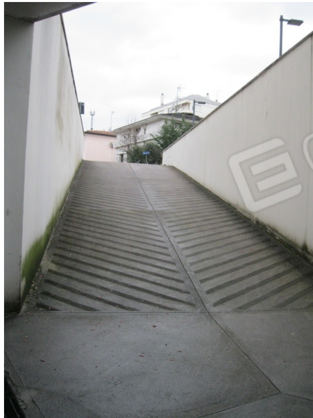
Foto 21 Rampa carrabile accesso garages
