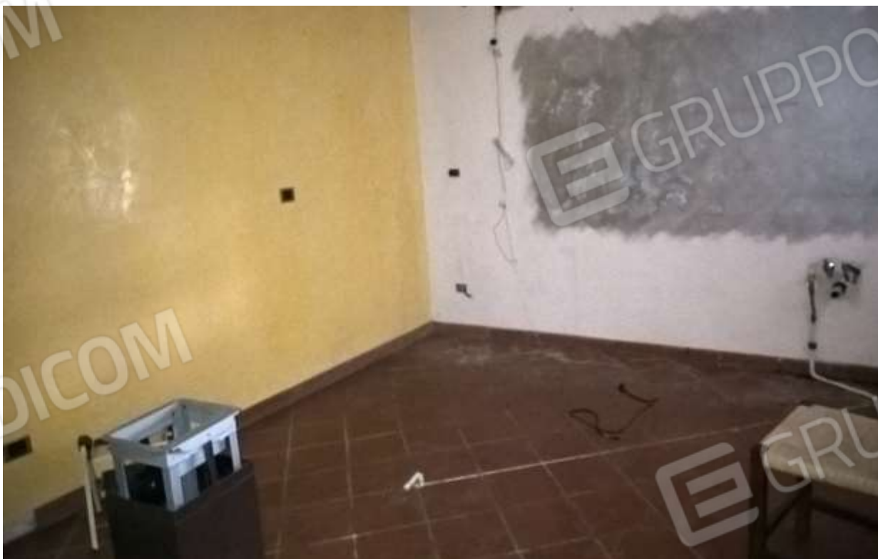
San Vito al Tagliamento, via Oberdan n. 84, piano terra – La lavanderia 1 (ex portico).
