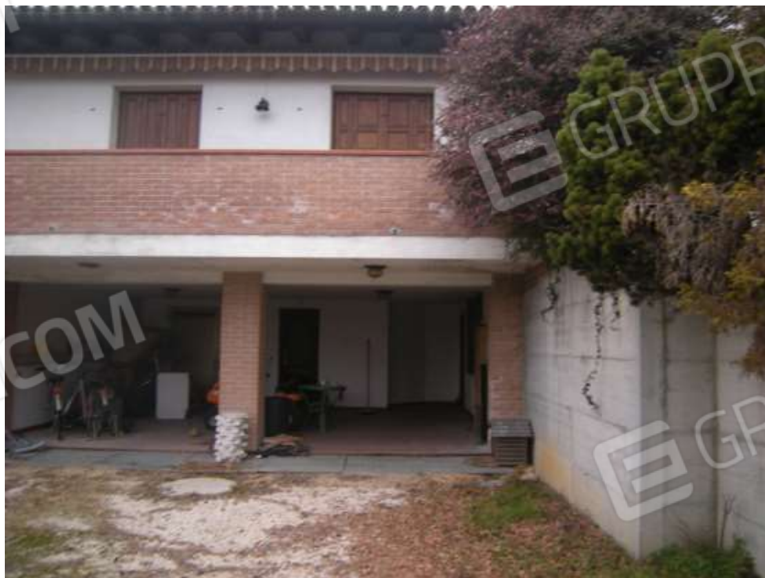
San Vito al Tagliamento, via Oberdan n. 84 – Il prospetto sud dell'edificio.
