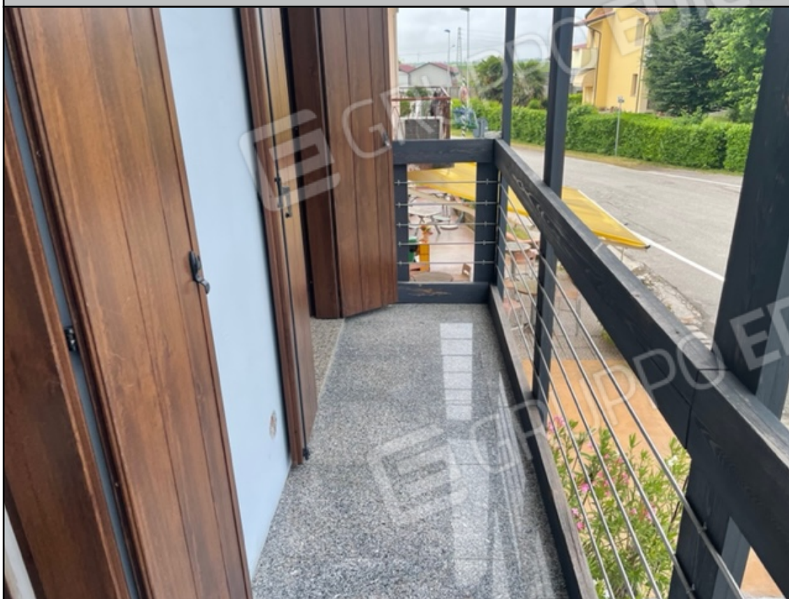
Balcone esterno, lato strada
