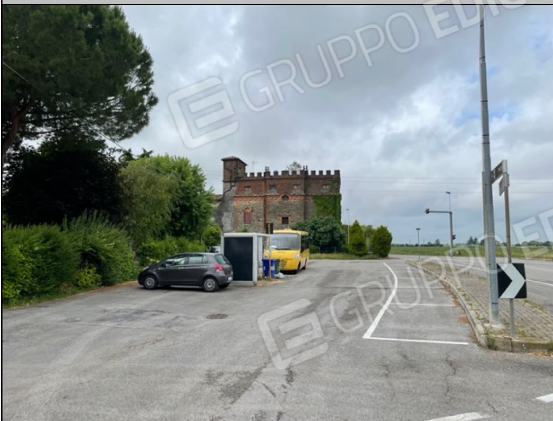
Vista fronte strada da immobile oggetto di stima
