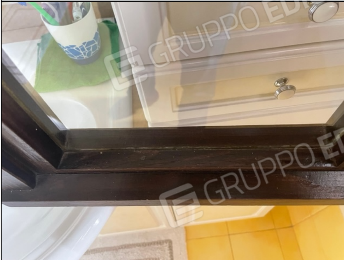
Infissi bagno a vetro singolo
