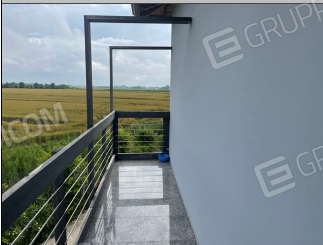
Balcone esterno, lato nord
