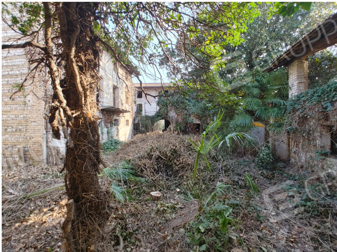
Foto 6 – Vista da Ovest verso Est nel cortile interno
