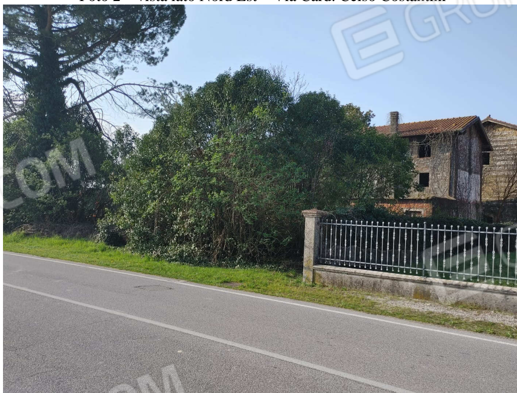
Foto 2 – vista lato Nord Est – Via Card. Celso Costantini
