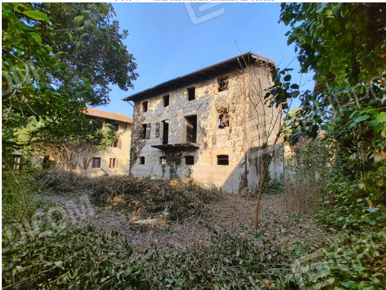
Foto 4 – vista fabbricato interno al cortile
