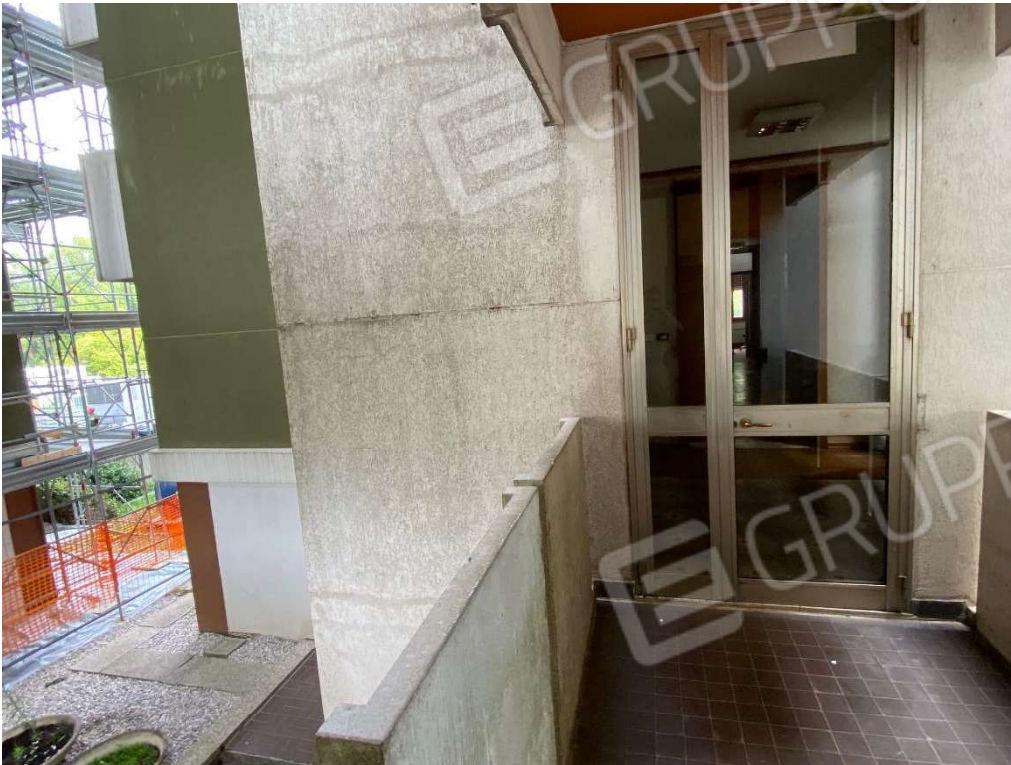
Ingresso al blocco "B" dal corridoio di collegamento esterno
