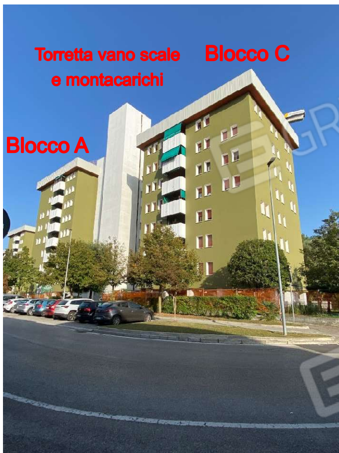
vista del fabbricato da Via del Maglio
