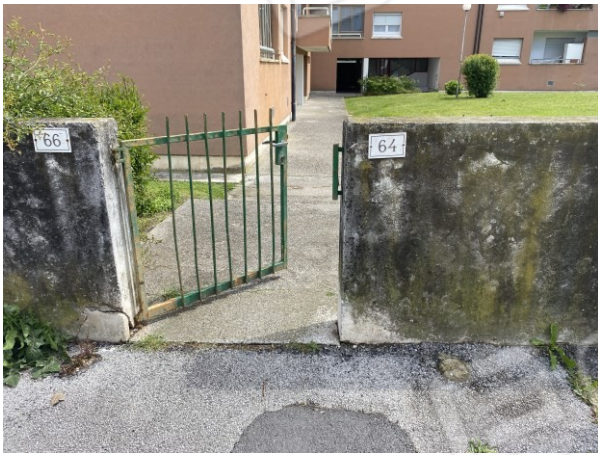
vista ingresso pedonale
