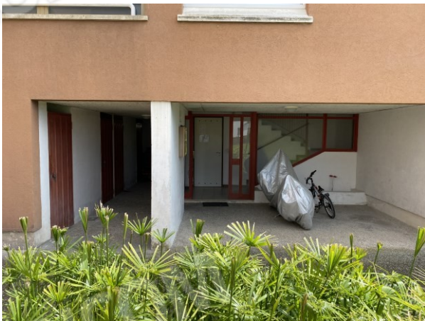
vista ingresso condominiale
