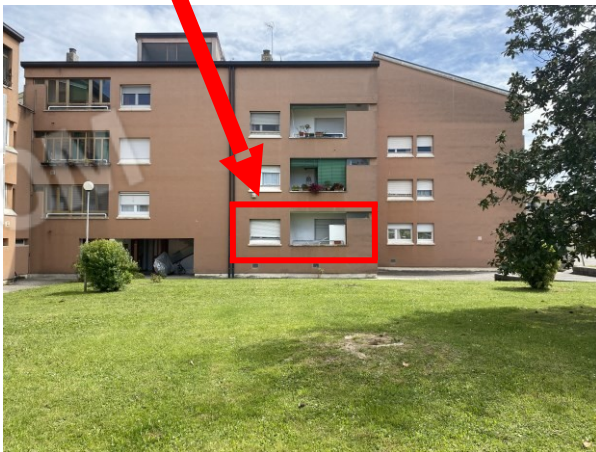
vista lato Ovest prospiciente strada
