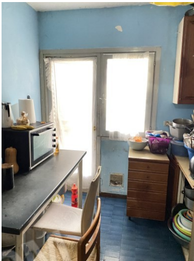
vista degrado in cucina
