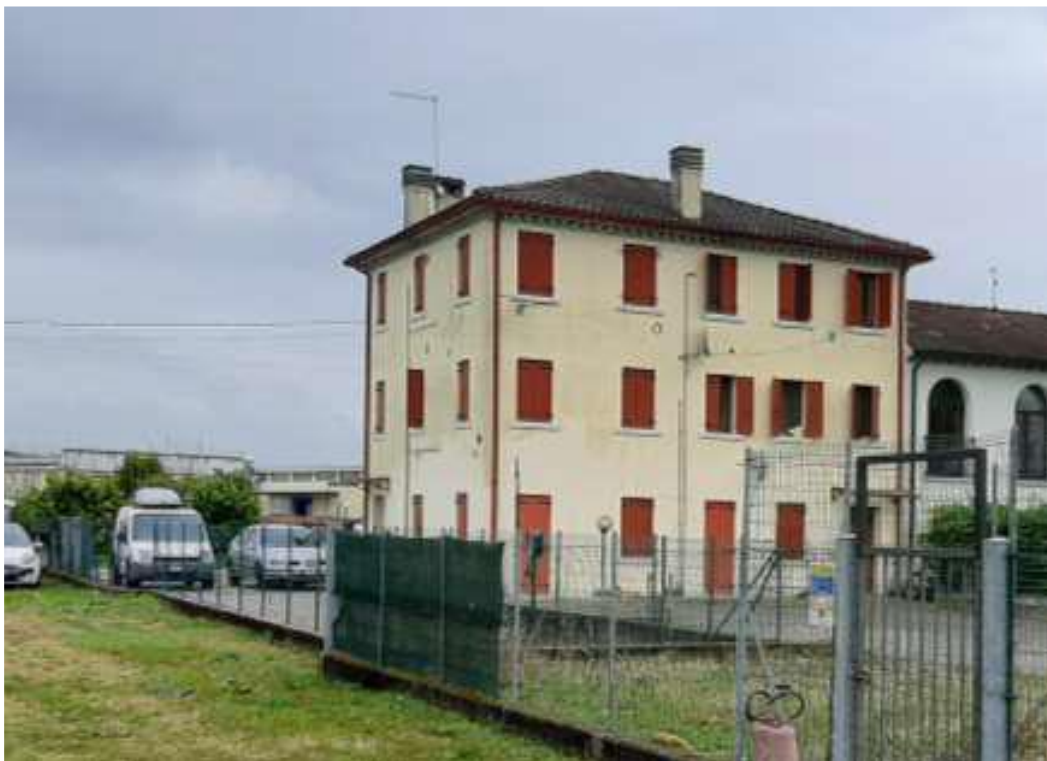
Vista generale degli esterni
