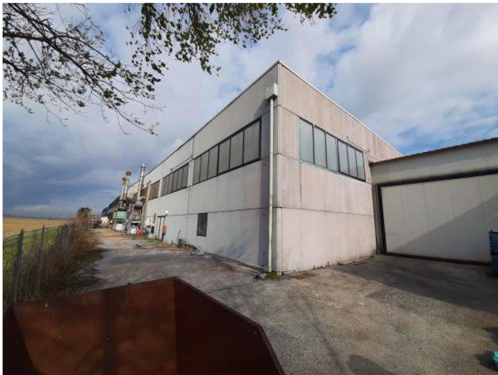
Vista generale degli esterni
