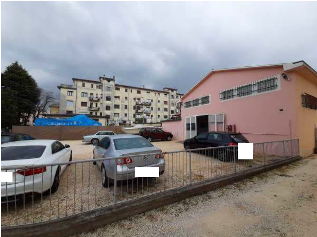
Vista generale degli esterni
