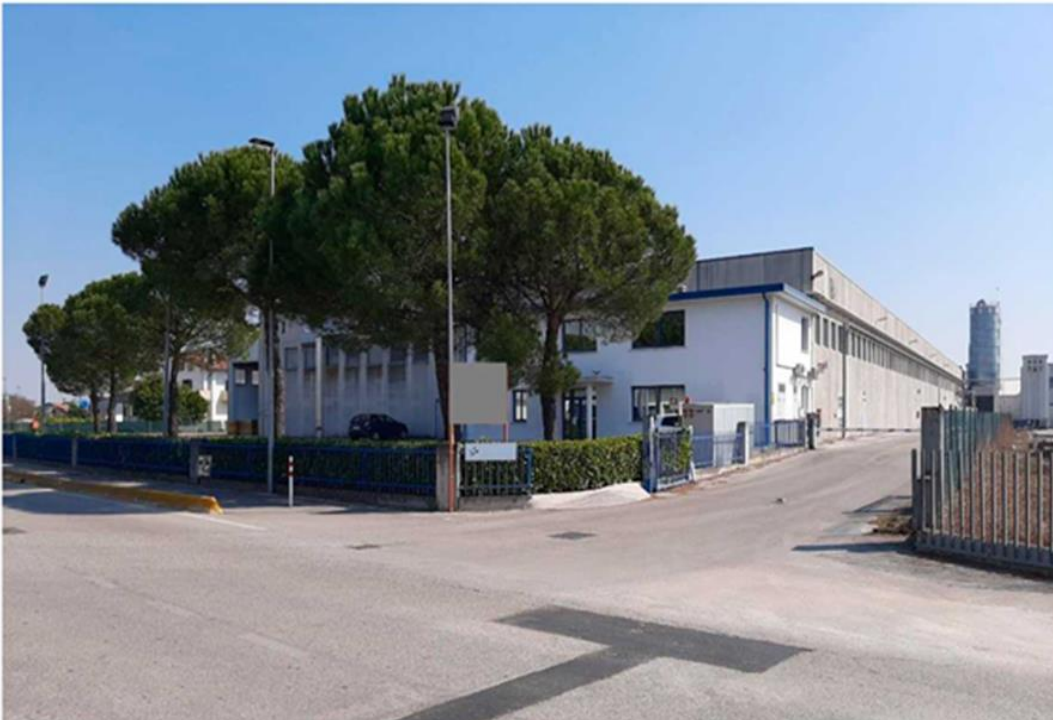
Vista generale degli esterni
