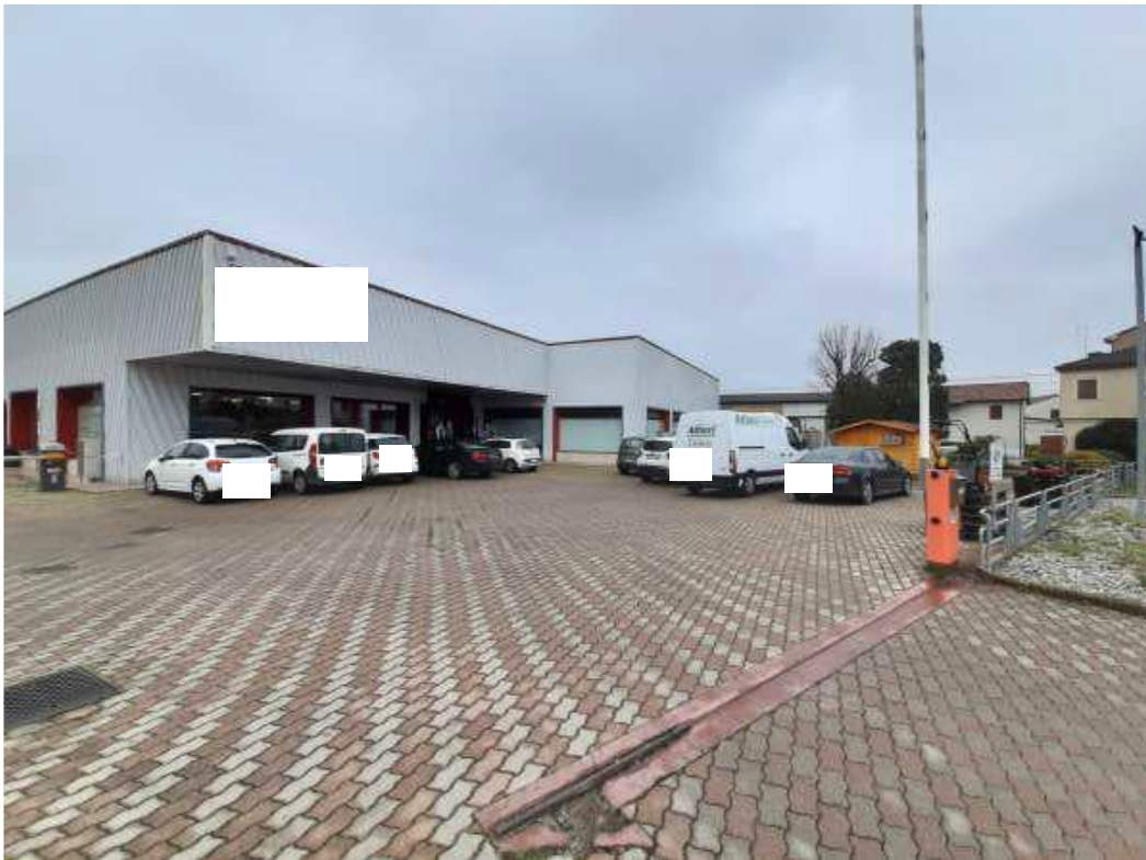
Vista generale degli esterni
