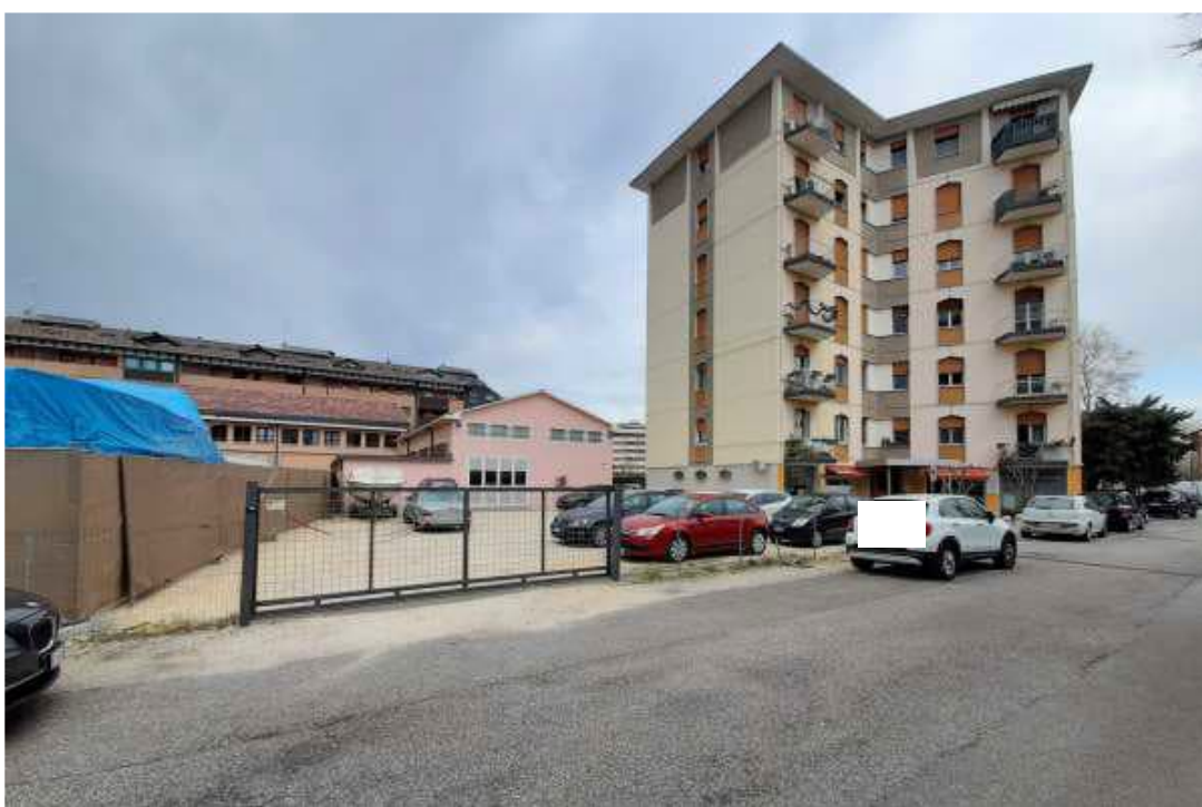
Vista generale degli esterni
