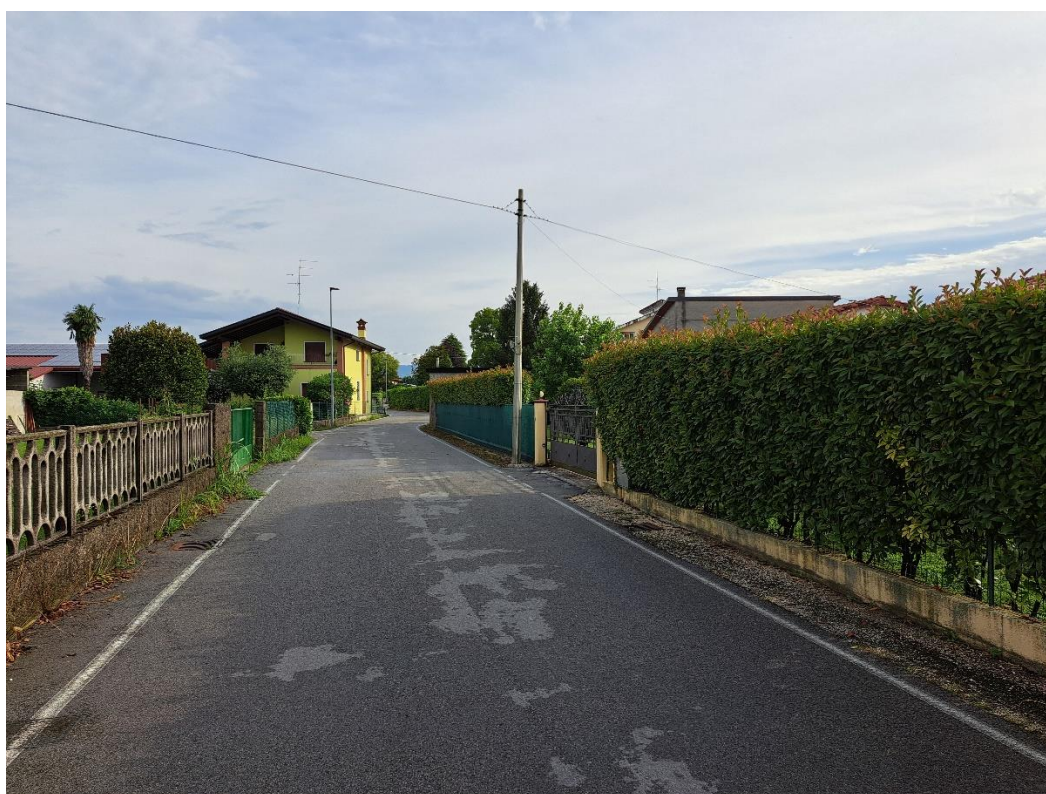
Lotto 5 – Comune di San Giorgio della Richinvelda Foglio 30 – Veduta, da Via S. Nicolò, della porzione stradale corrispondente alla particella n. 1122, posta a destra nella foto.
