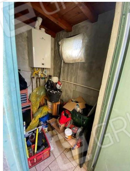
vista interna ripostiglio/centrale termica
