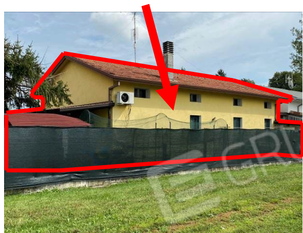
vista prospetto lato ovest abitazione
