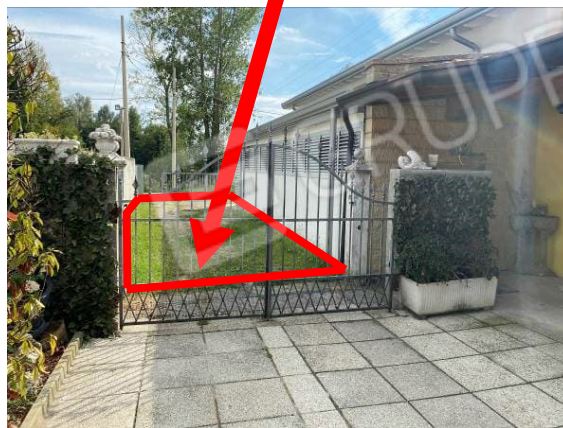
particolare servitù attiva di transito attraverso il mappale 387 del foglio 26 di Pordenone di proprietà terzi per accedere al fabbricato d'abitazione
