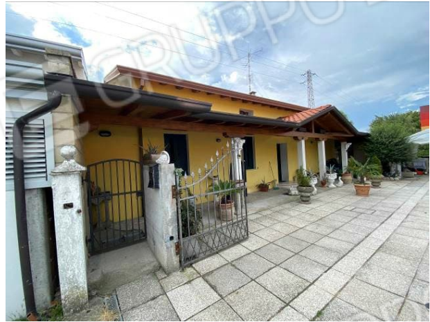
vista portico abusivo
