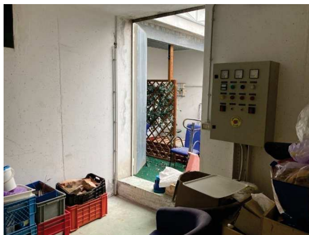
particolare interno ripostiglio comune
