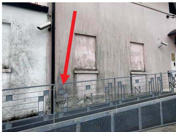
particolari degrado muratura esterna
