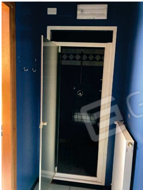
vista doccia e antibagno
