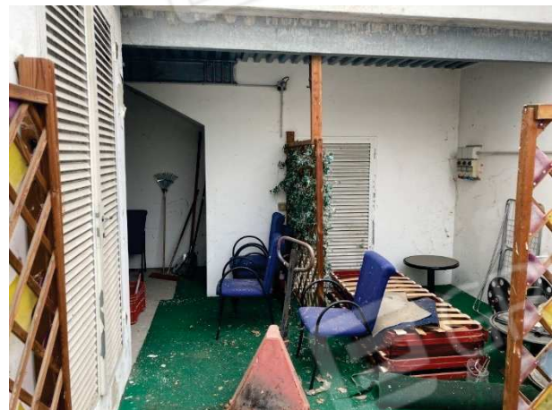
particolare ingresso magazzino sub. 14
