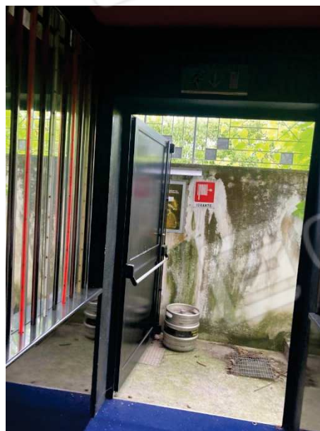
vista uscita di emergenza lato Ovest
