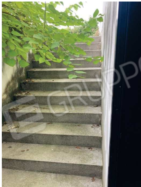
ulteriore vista scala esterna uscita di emergenza lato Ovest fabbricato
