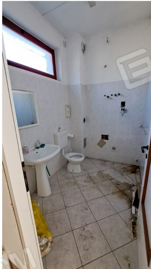
20 - bagno piano terra
