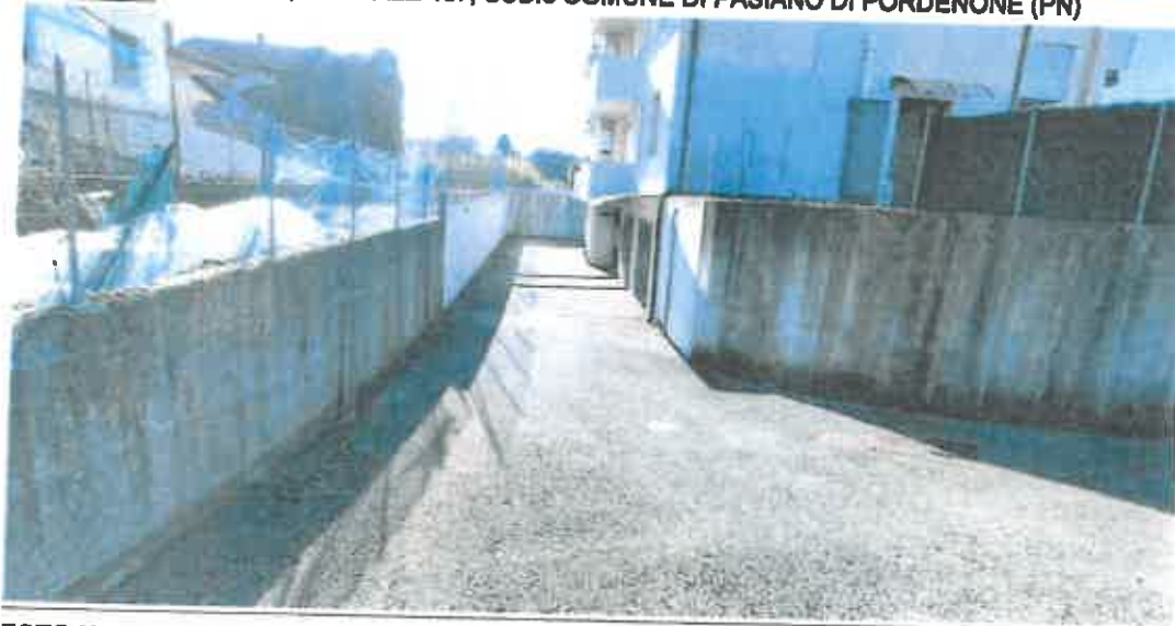
FOTO N.05 FOGLIO 8, MAPPALE 457, SUB.8 COMUNE DI PASIANO DI PORDENONE (PN)
