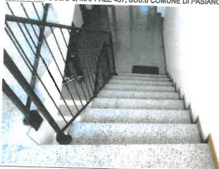
FOTO N.34 FOGLIO 8, MAPPALE 457, SUB.6 COMUNE DI PASIANO DI PORDENONE (PN)
