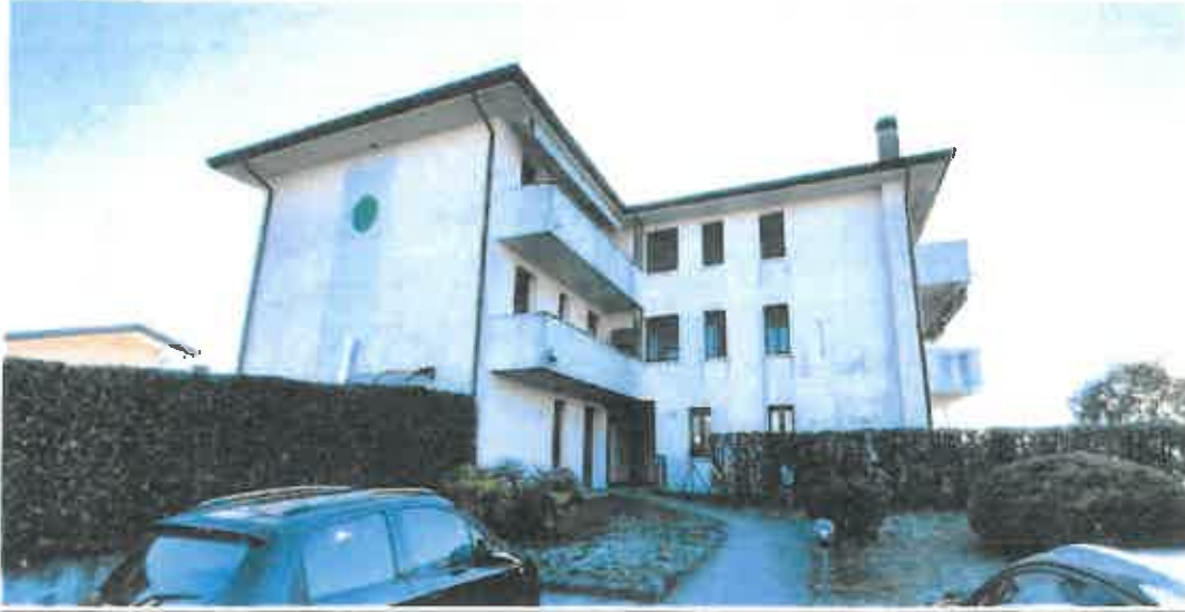
FOTO N.02 FOGLIO 8, MAPPALE 457, SUB.6 COMUNE DI PASIANO DI PORDENONE (PN)
