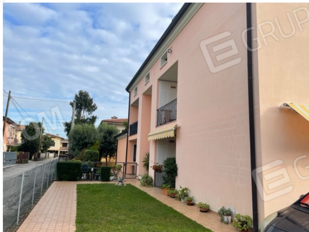
Vista esterna dell'immobile, facciata di lato via Bruttomesso
