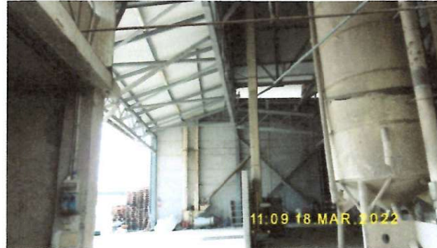
TETTOIE E SILOS
