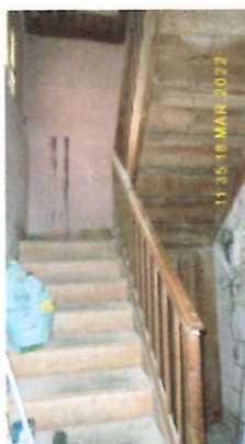
SCALA DA PIANO TERRA A PIANO PRIMO
