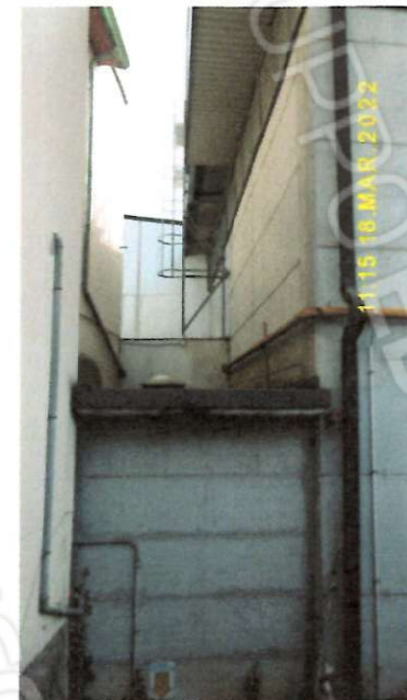
VISTA NORD-OVEST DEPOSITO
