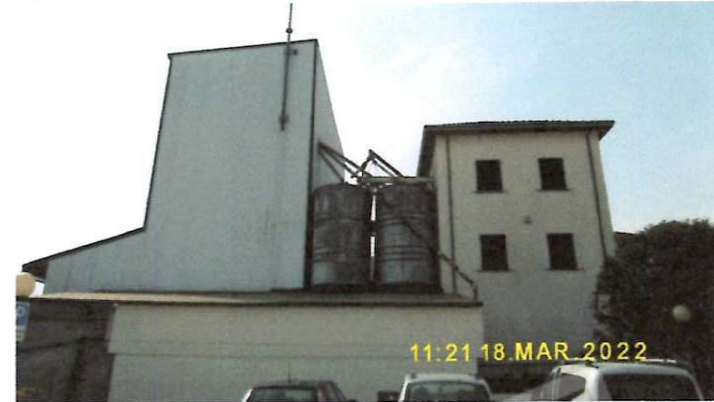
VISTA NORD-EST TETTOIE
