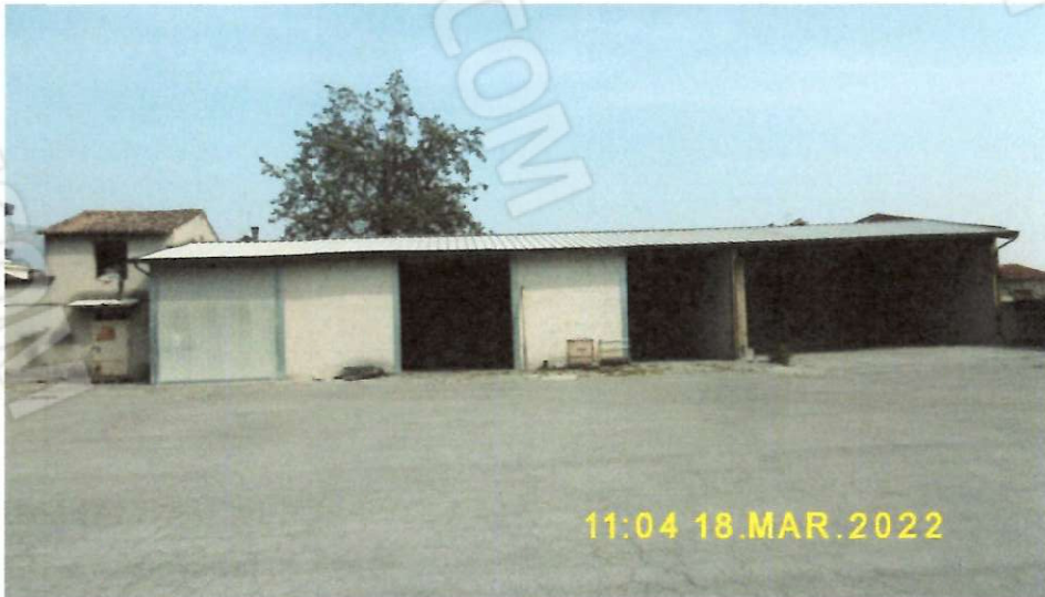
VISTA SUD-EST MAGAZZINI
