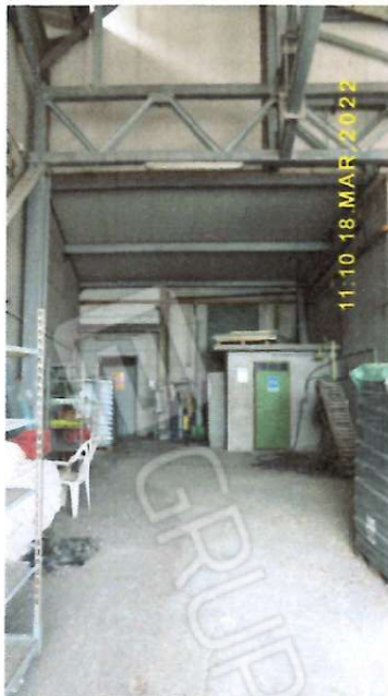
DEPOSITO E W.C.
