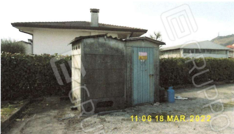
VISTA NORD-EST BOX PREFABBRICATO
