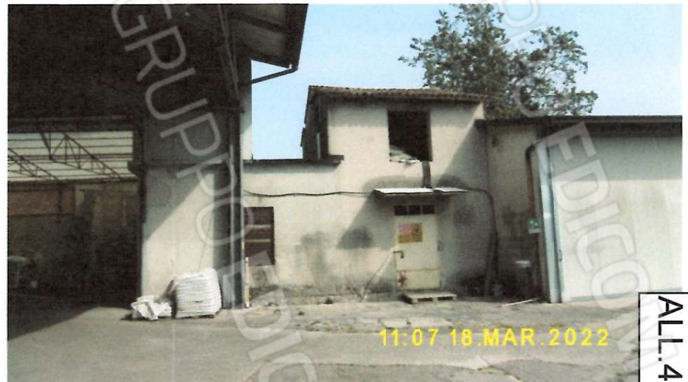
VISTA SUD-EST MAGAZZINI
