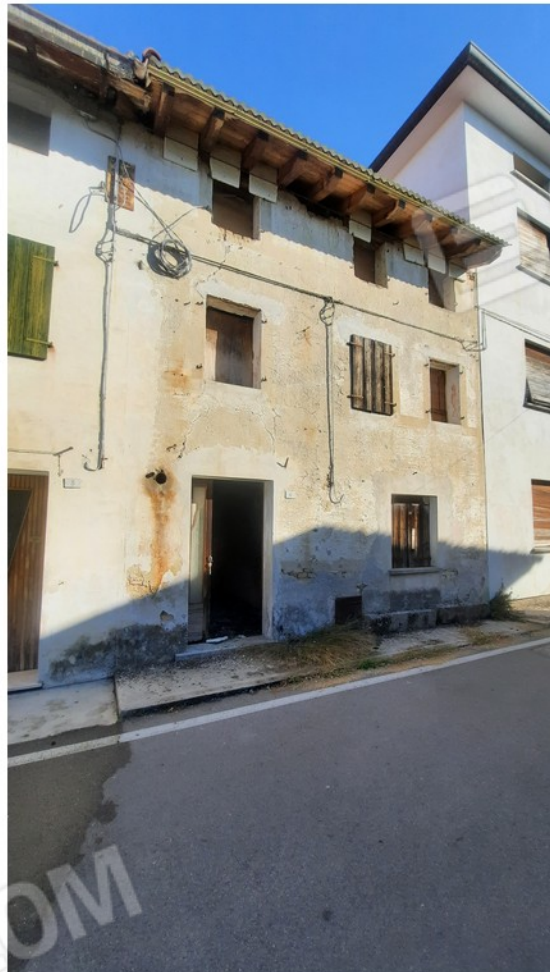
2 - fronte su via marconi
