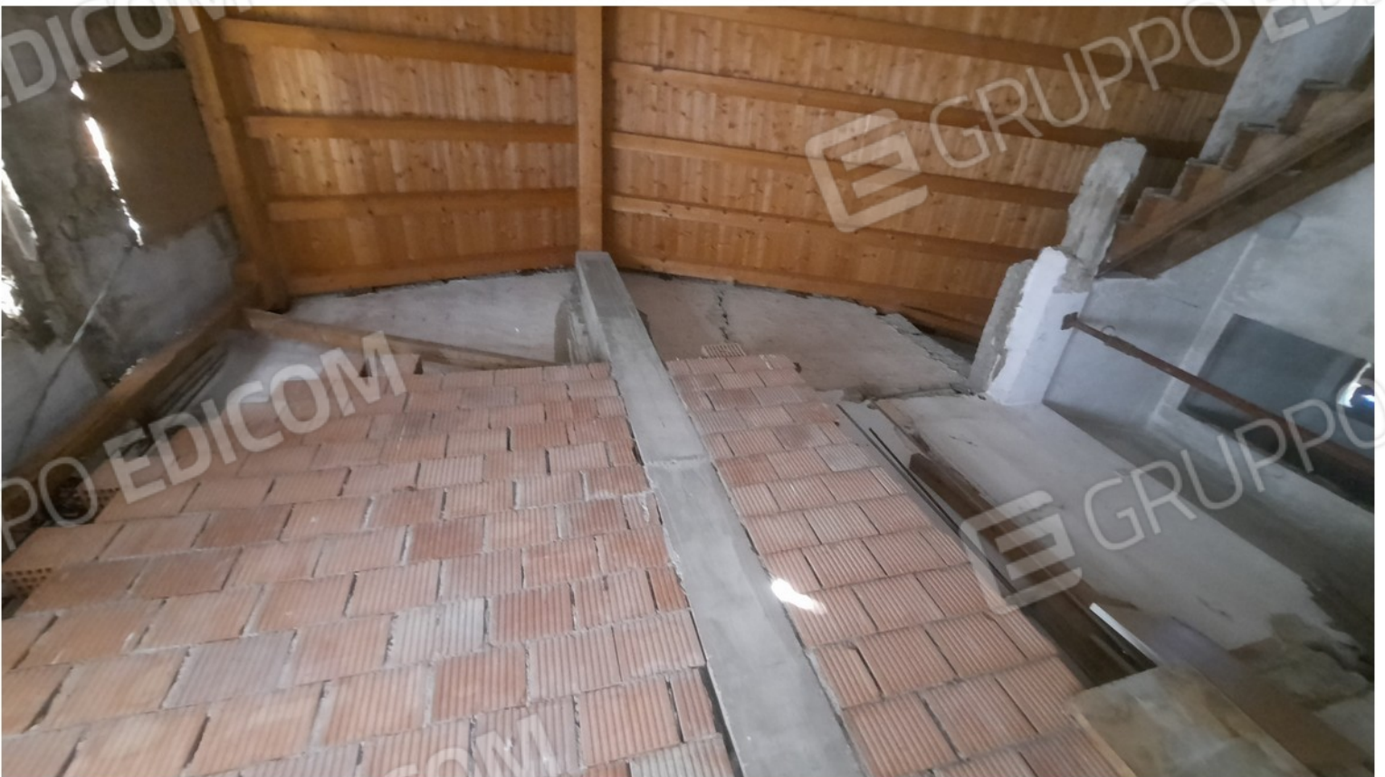
14 - copertura struttura interna
