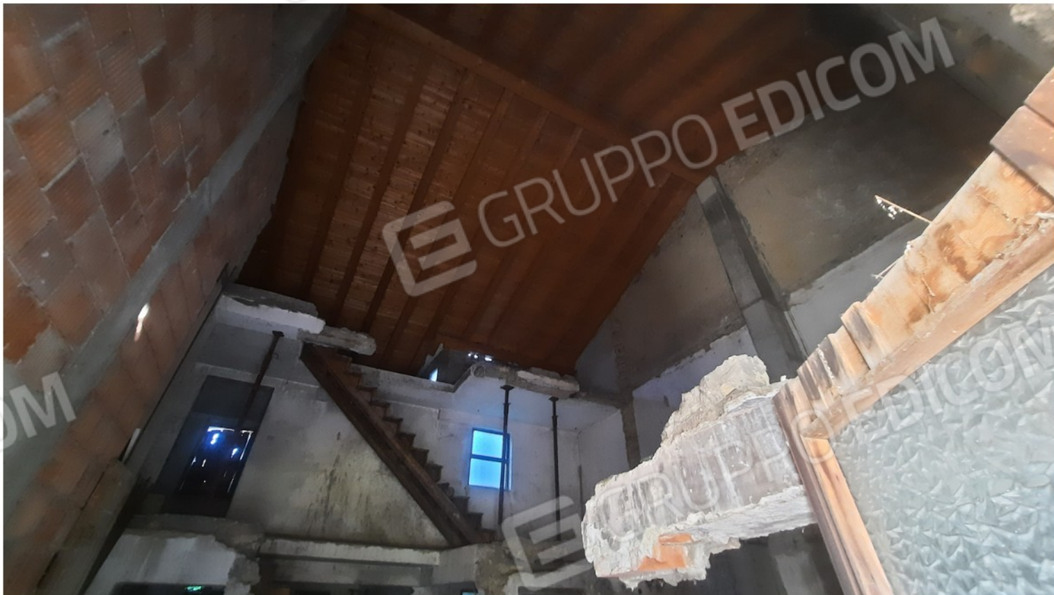
9 - interno copertura e struttura
