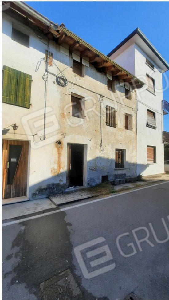
1 - fronte su via marconi
