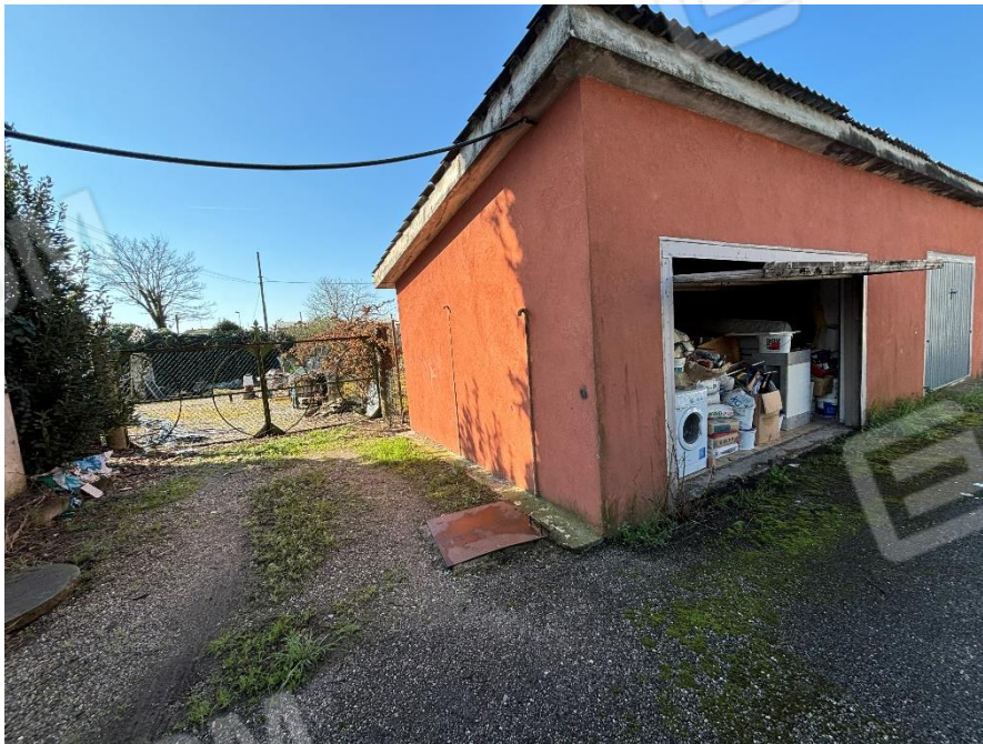
Vista esterna Garage
