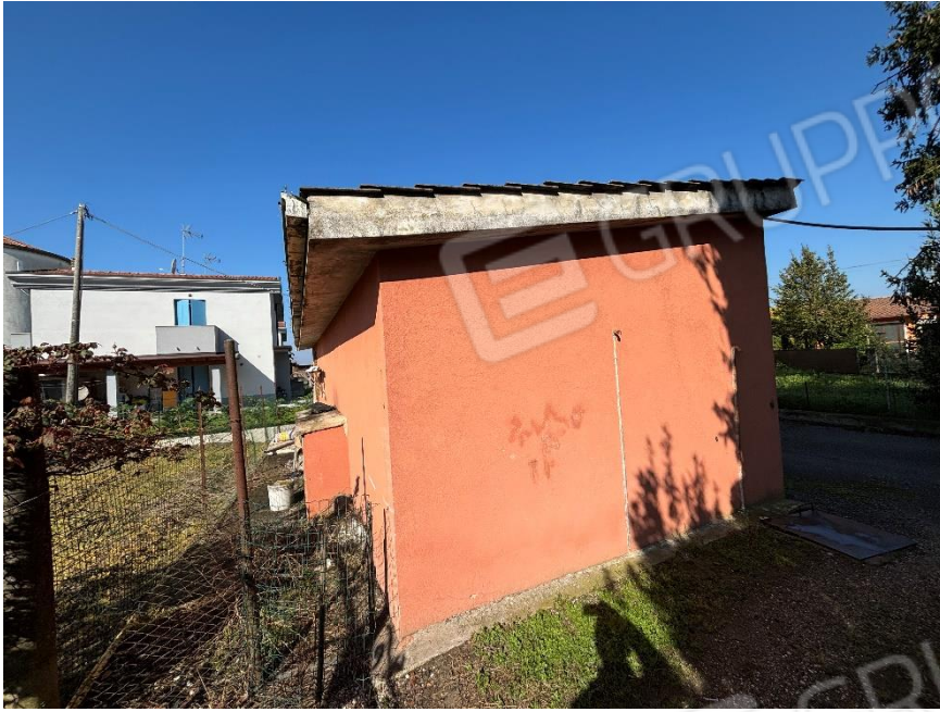
Vista esterna Garage
