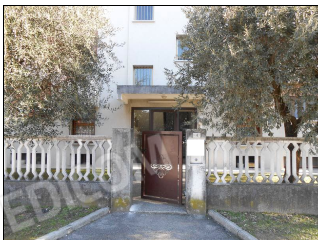
5) 6) Ingresso pedonale al civico n. 4 di via Del Geniere
