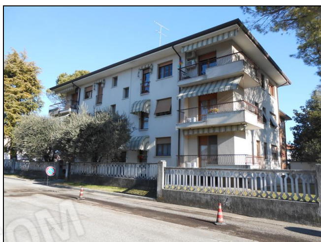
3) Fronte sulla strada
