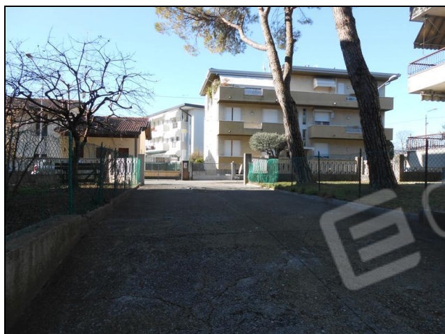
35) Rampa carrabile di accesso ai garages
