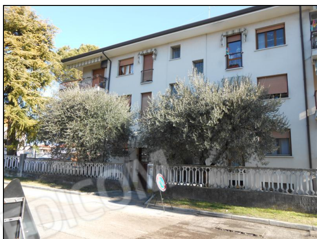
39) Veduta del fabbricato dalla strada
