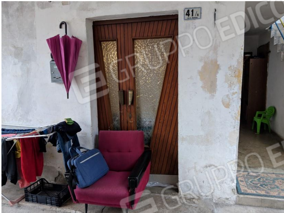
FOTO 9: ACCESSO DAL PORTICATO AL SOGGIORNO (P.T. – corpo principale)
