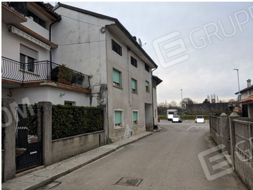
FOTO 2: PANORAMICA DEL FABBRICATO DA VIA CESARE BATTISTI
