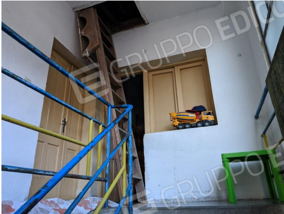
FOTO 29: SCALA ESTERNA PER ACCESSO ALLA SOFFITTA
