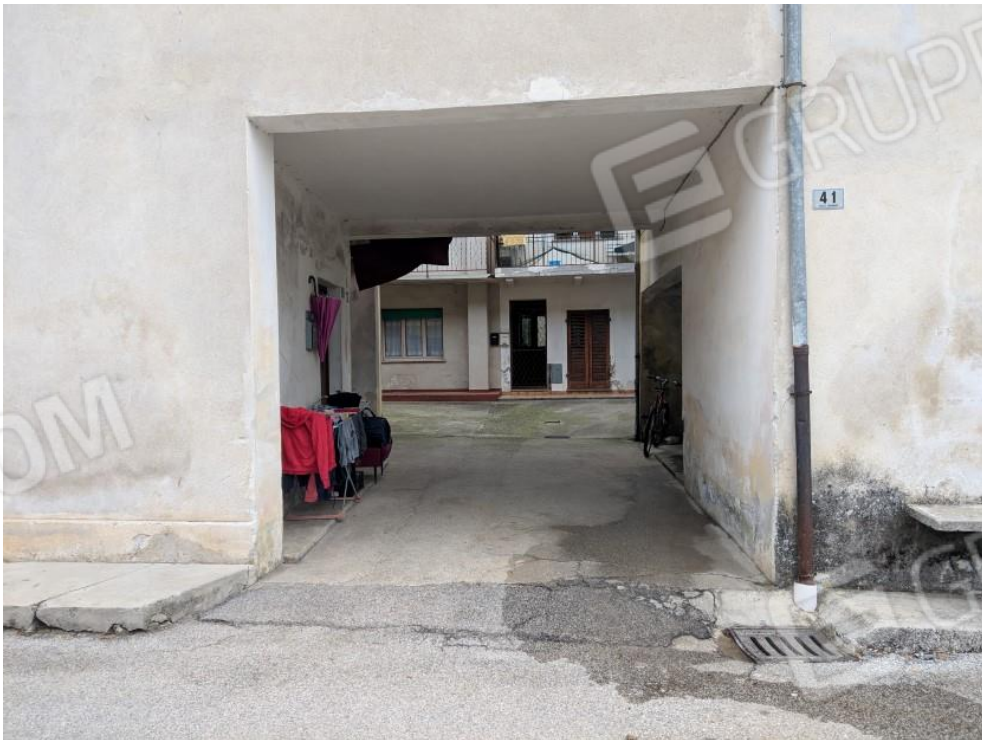
FOTO 6: PORTICATO AL PIANO TERRA
