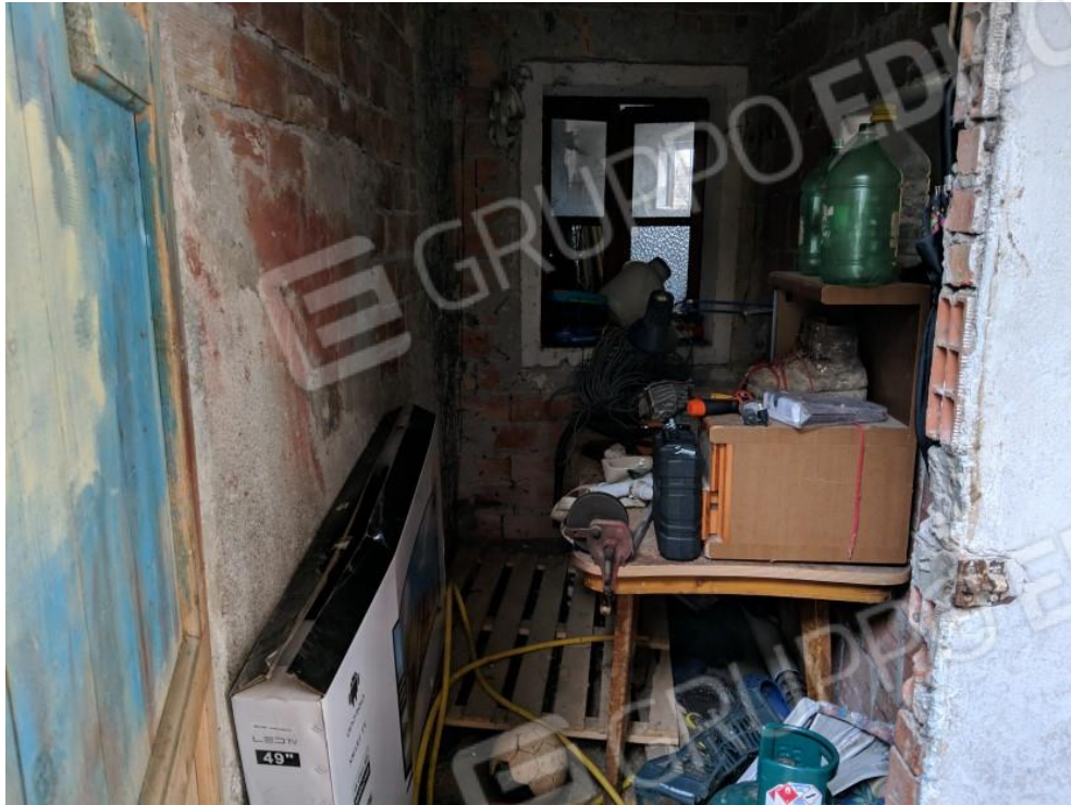
FOTO 15: RIPOSTIGLIO (P.T. – corpo accessori)
