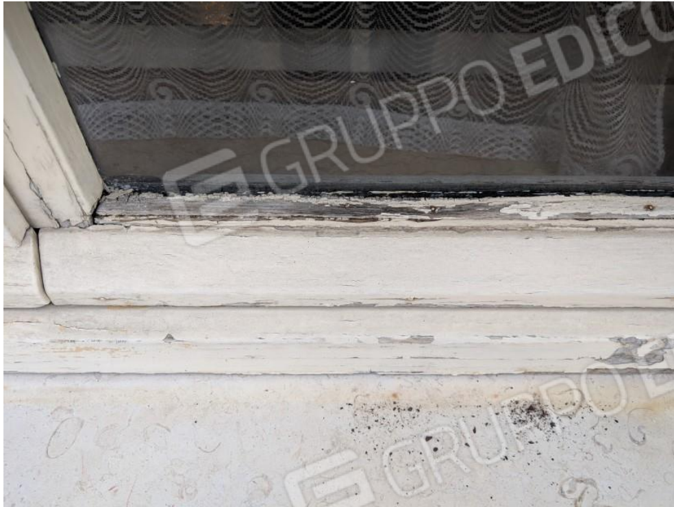
FOTO 33: PARTICOLARE DEL SERRAMENTO (FINESTRA)
