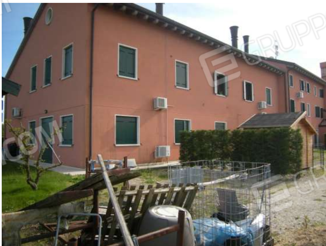
Ottava Presa (Caorle), Strada Fortuna n. 56 – Sopra i prospetti a sud-est e nord-ovest, sotto i prospetti ad nord -ovest ed a nord – est.
