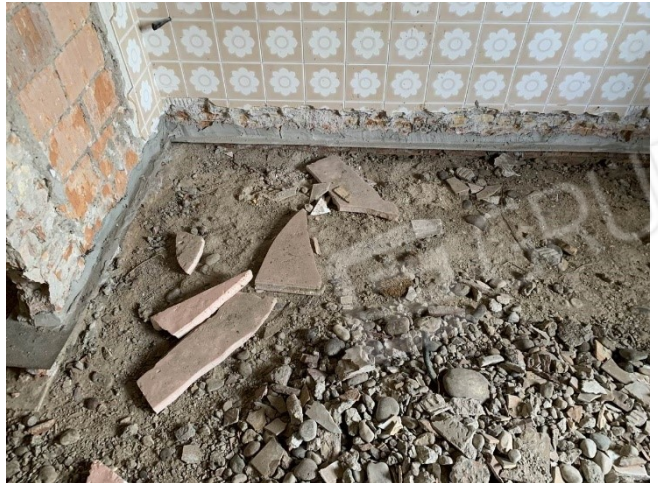
ulteriori particolari del taglio meccanico nelle murature interne
